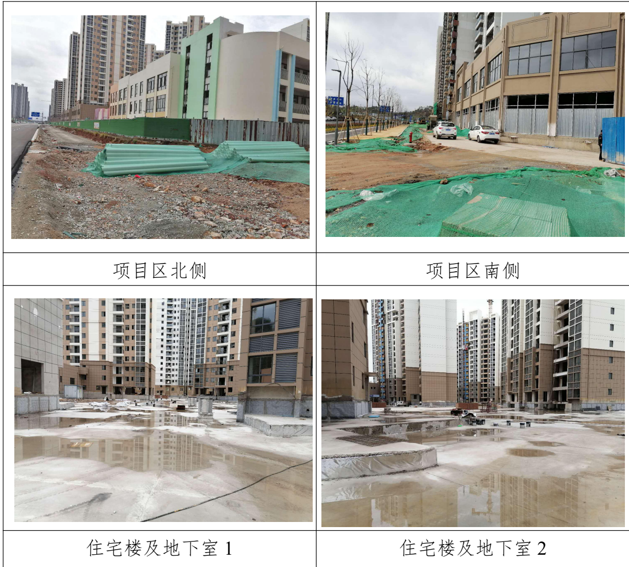
图 1-1 项目区现状照片
