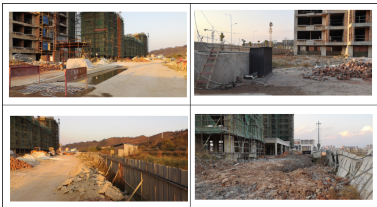
图 1-1 项目区施工现场照片
