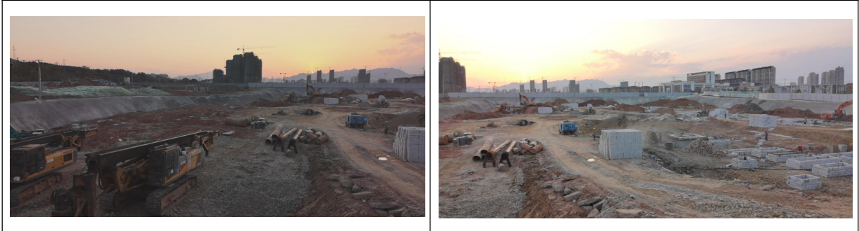
图 1-1 项目区施工现场照片
