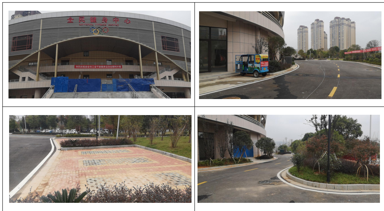
图 1-1 项目区施工现场照片
