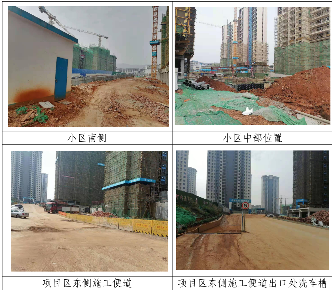
图 1-1 项目区施工现场照片
