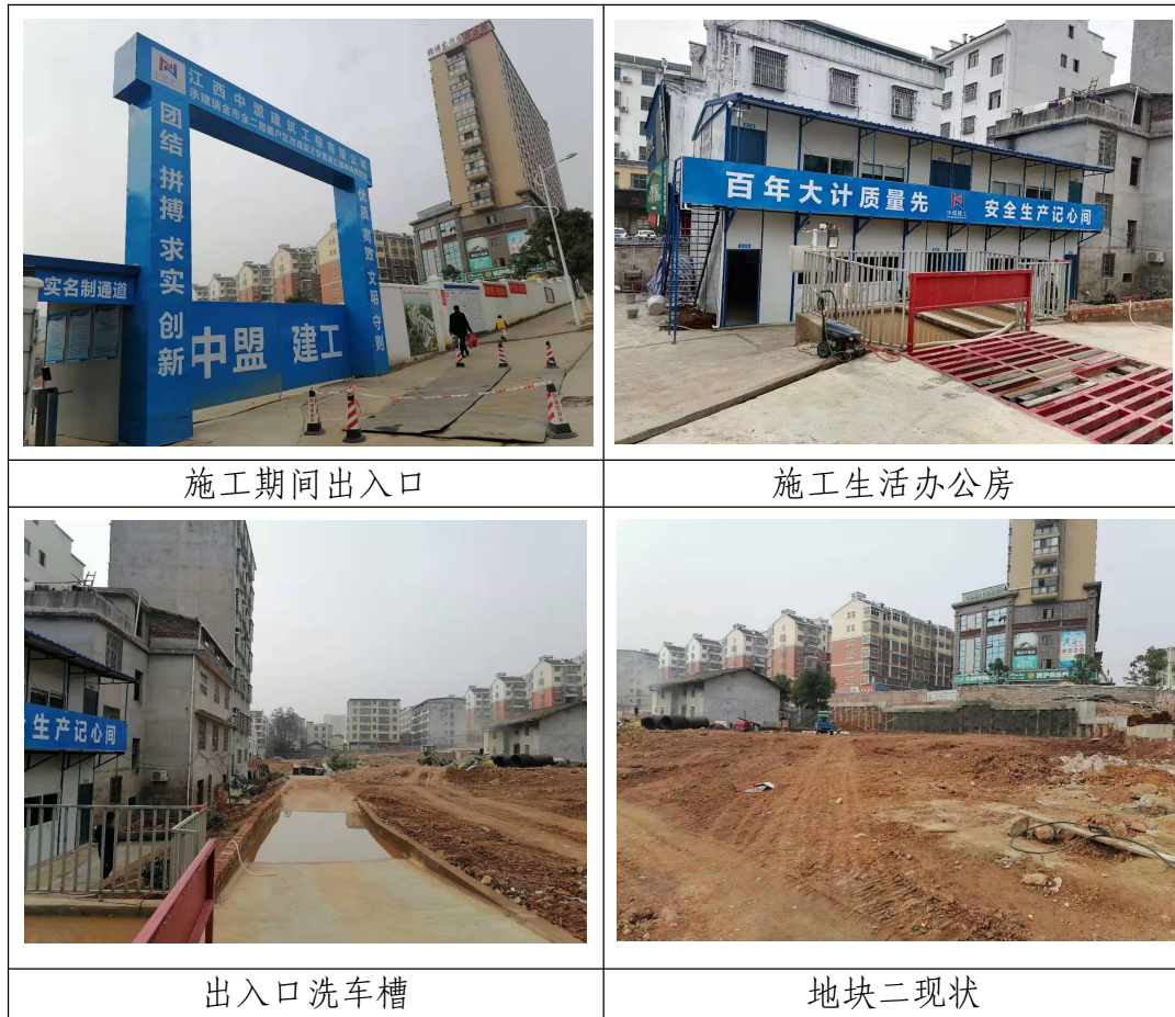
图 1-1 项目区施工现场照片
