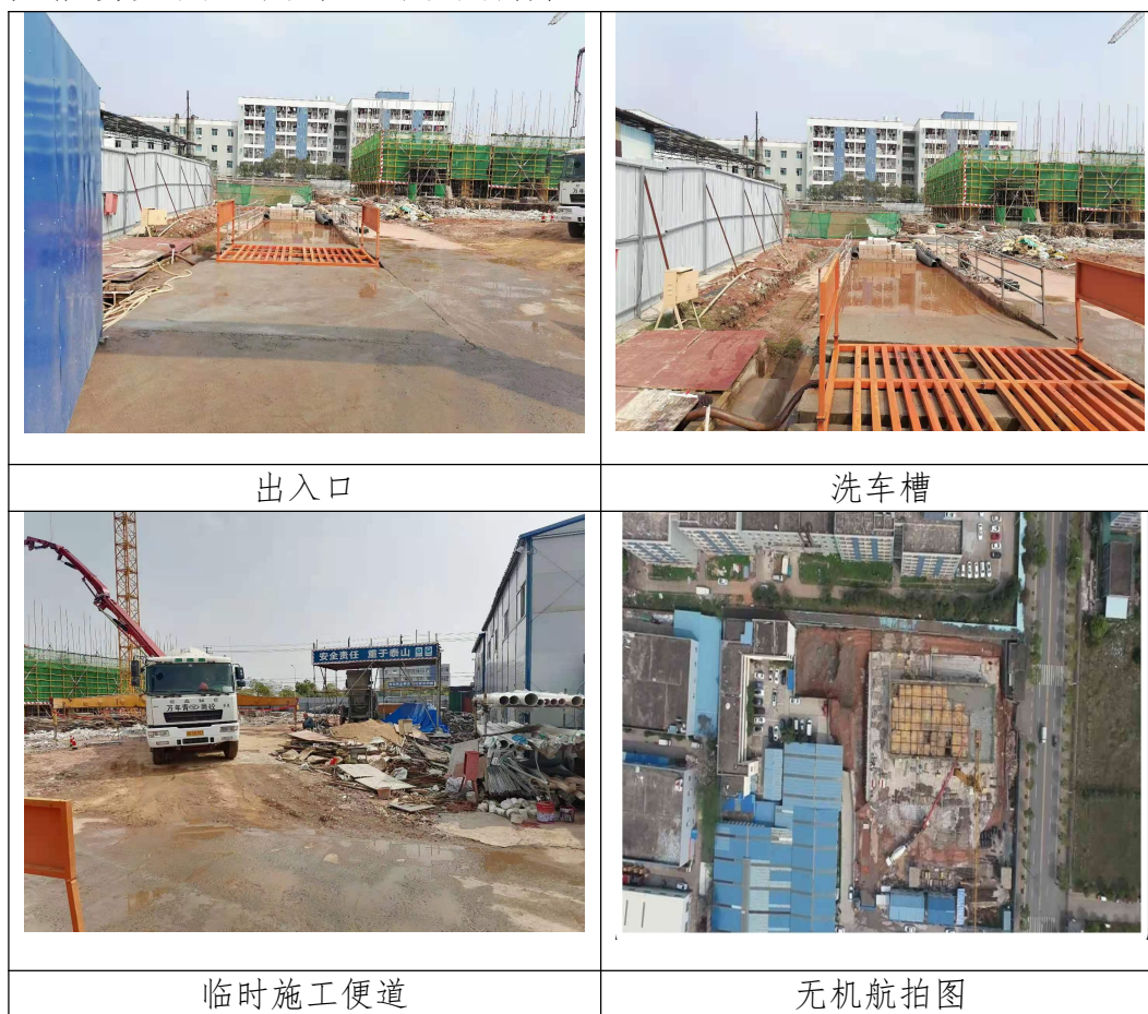
图 1-1 项目区施工现场照片
