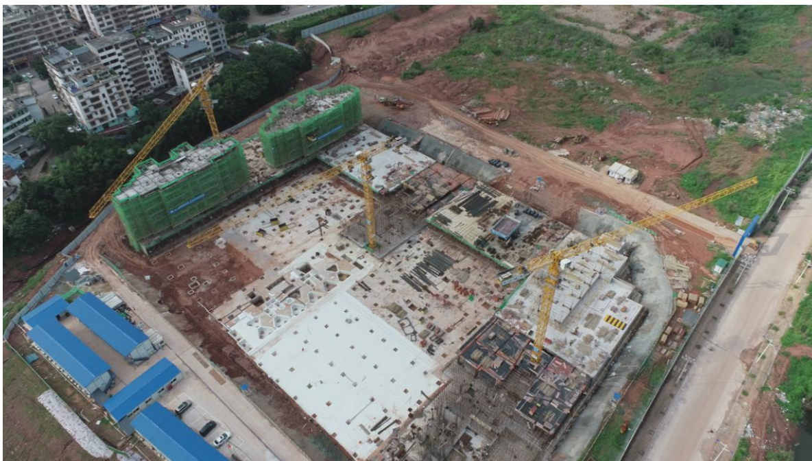
图 3-1 项目区施工现状与周边原地貌照片
