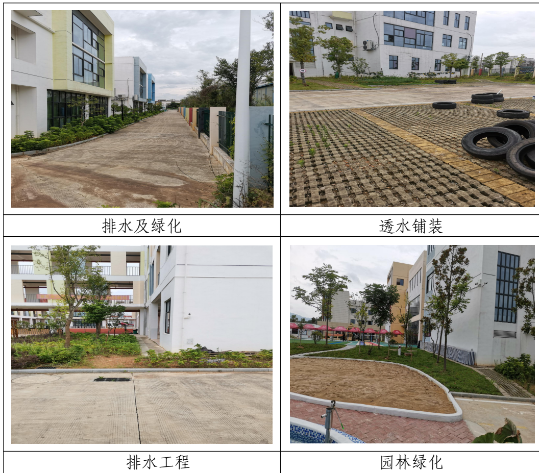
图 2-1 项目区现场照片
