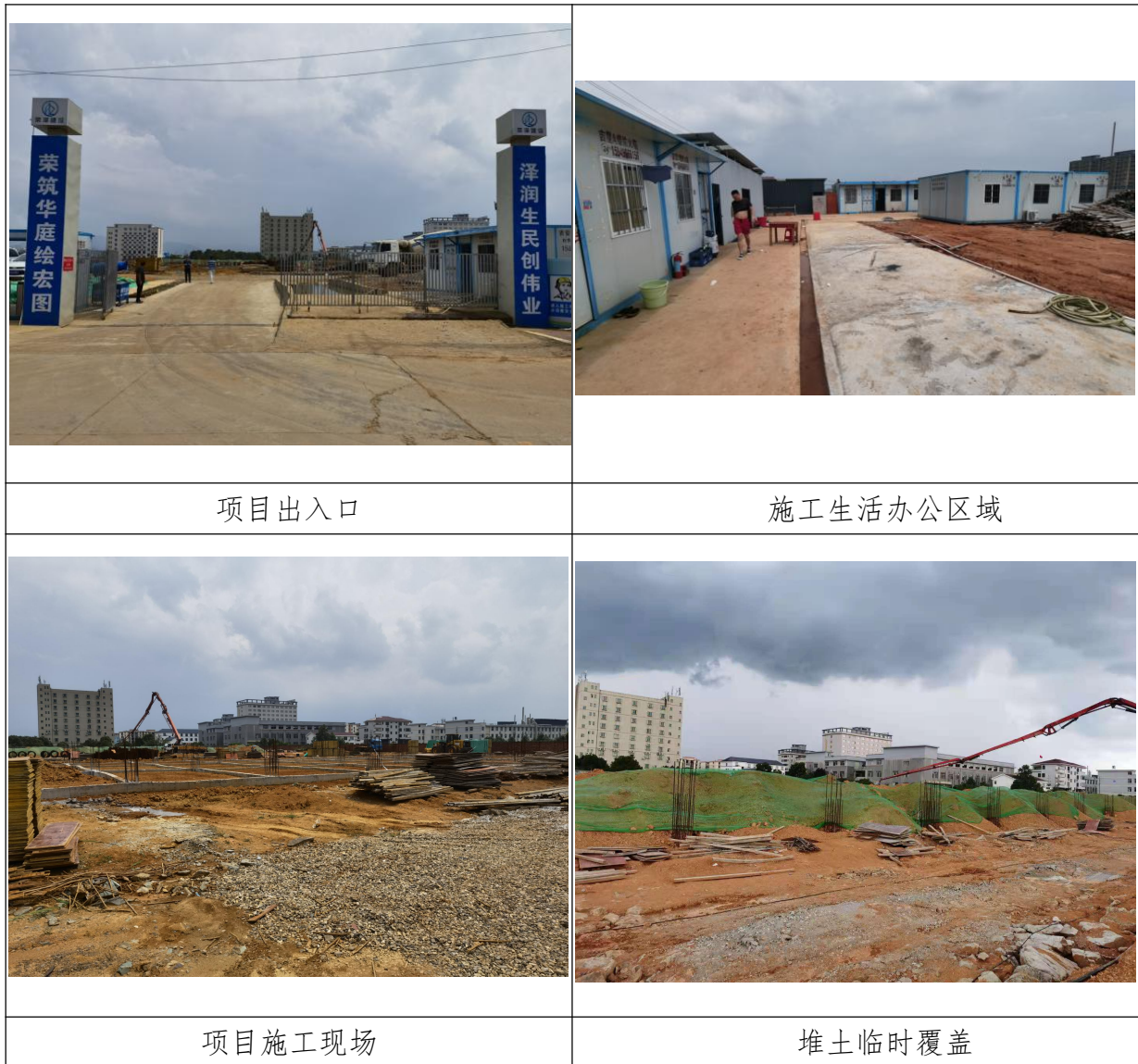
图 1-1 项目区现状照片
