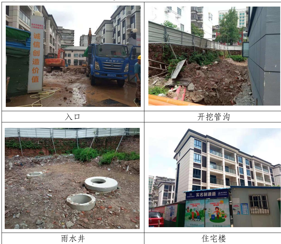
图 1-1 项目区现状照片
