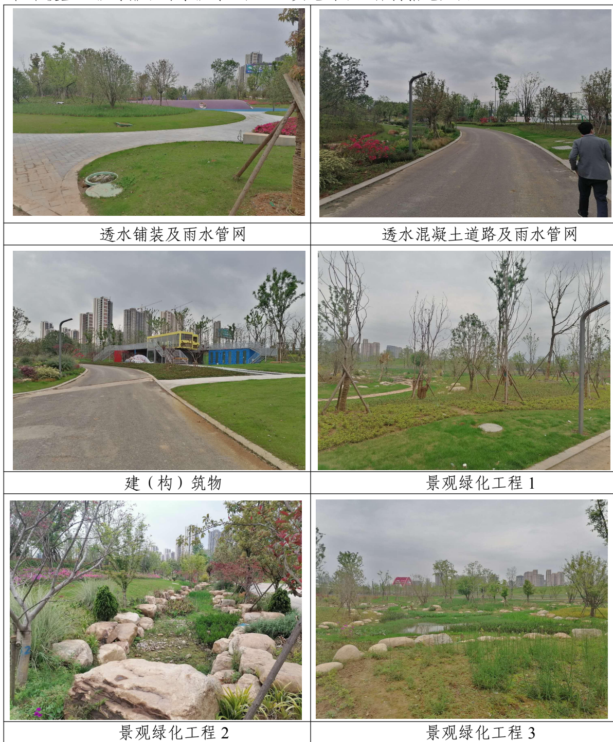
图 3-1 主体工程中已实施的水土保持措施
