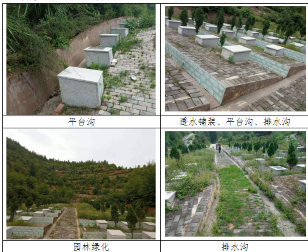
图 2-1 项目区现状情况
