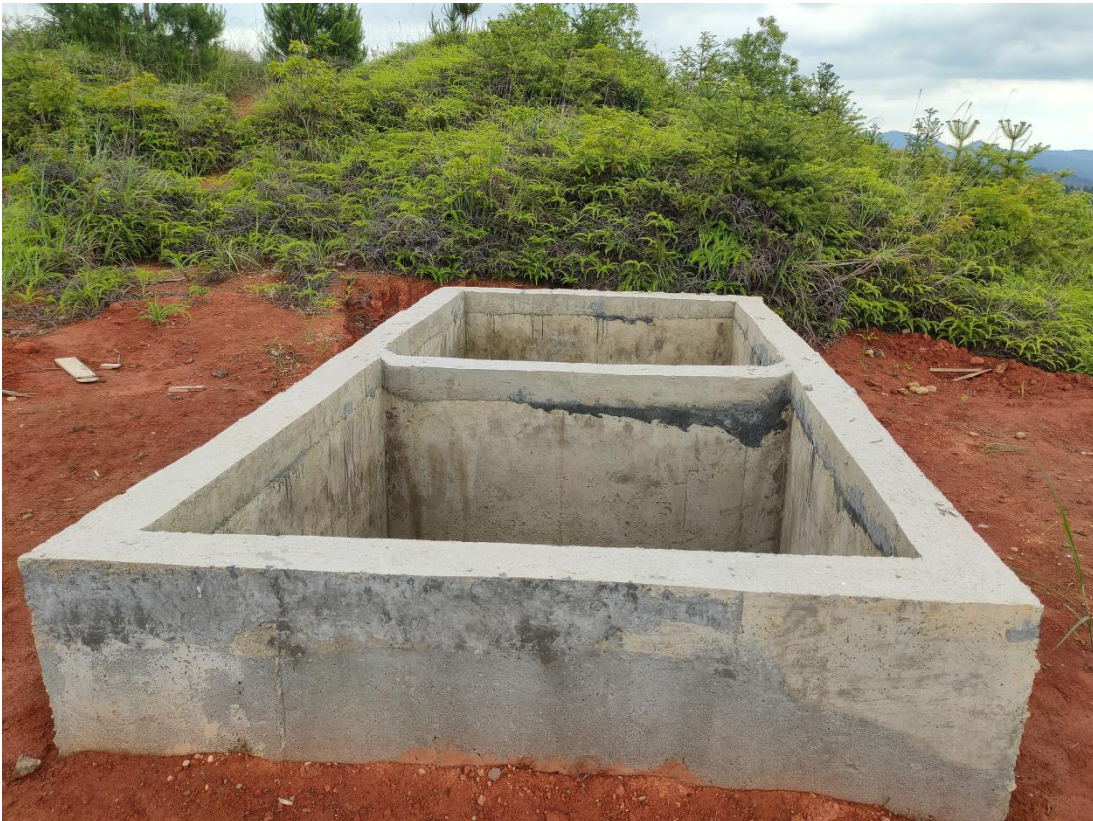
梯田工程区域沉沙池现状（2021年5月）
