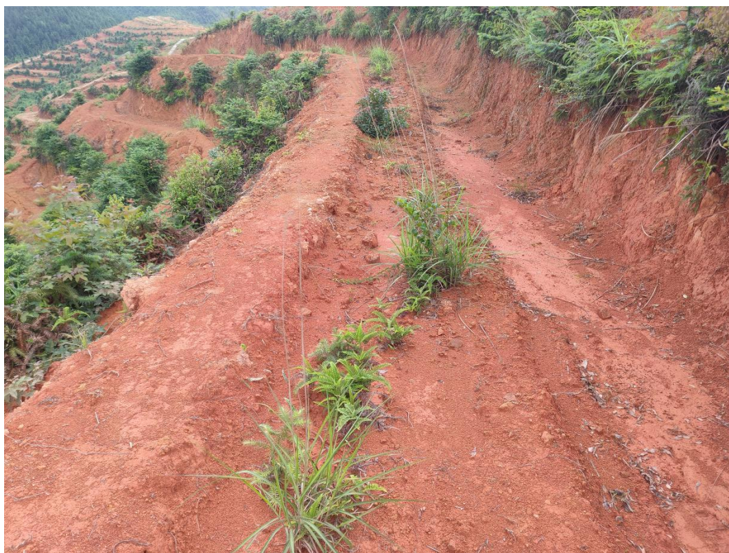
梯田工程区条播植草现状（2021年5月）
