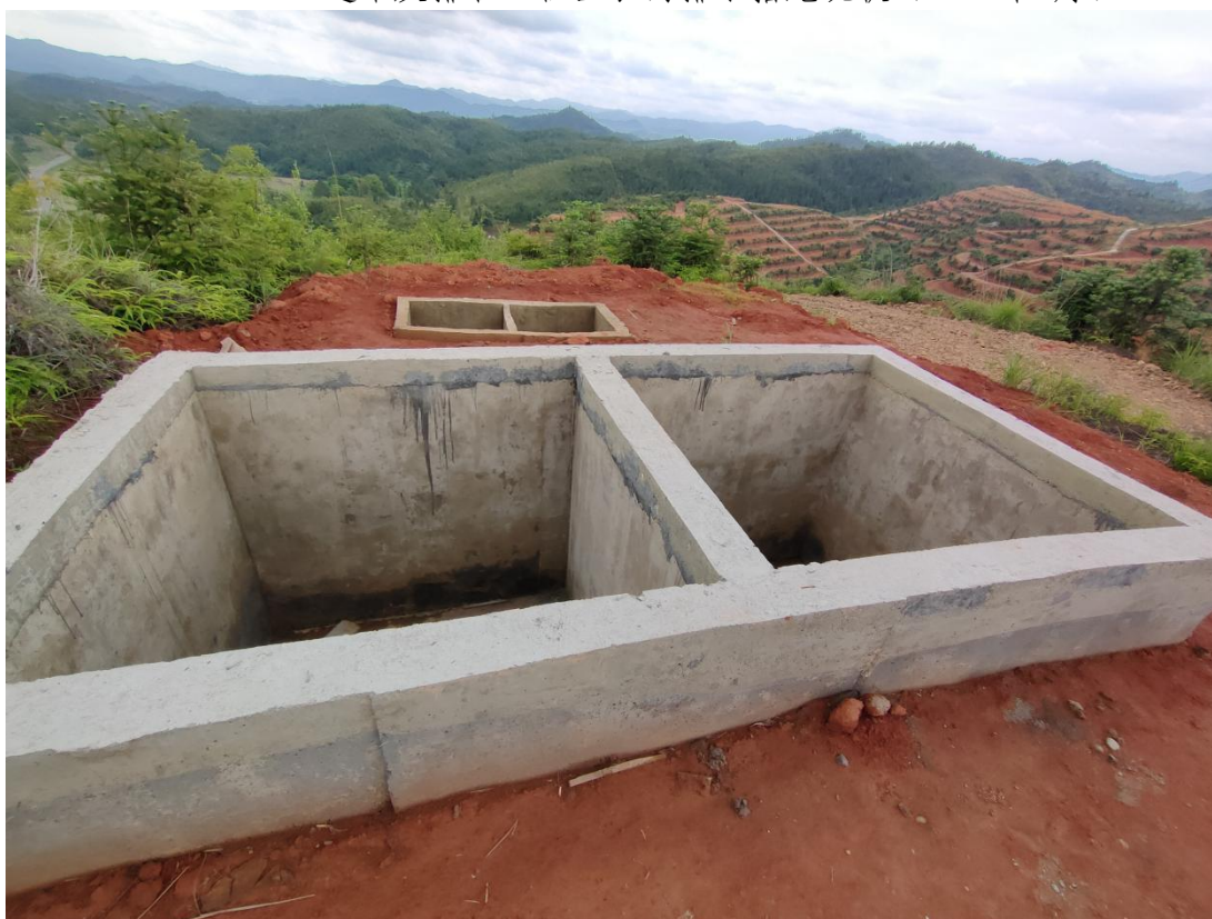
梯田工程区域沉沙池现状 (2021年5月)
