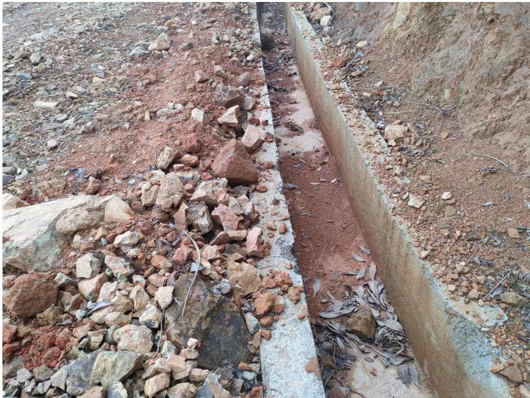
道路及排灌工程区农沟排水措施现状 (2021年5月)
