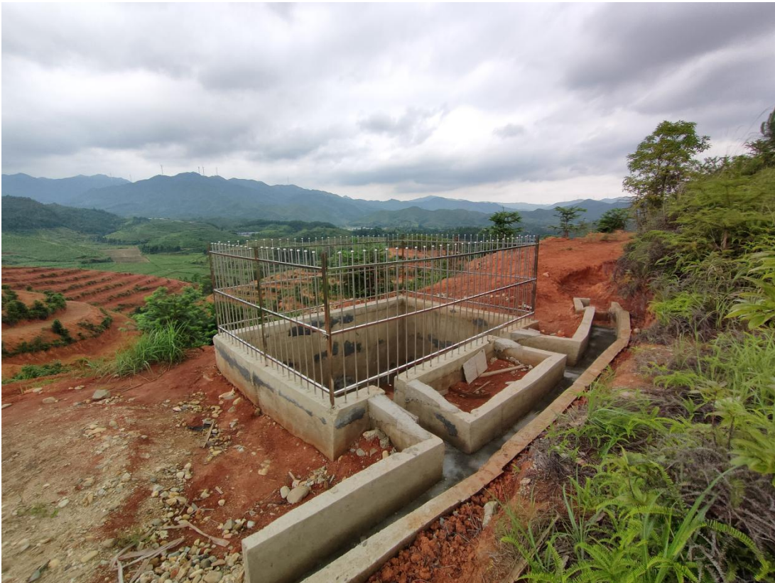
梯田工程区域沉沙池现状 (2021年5月)
