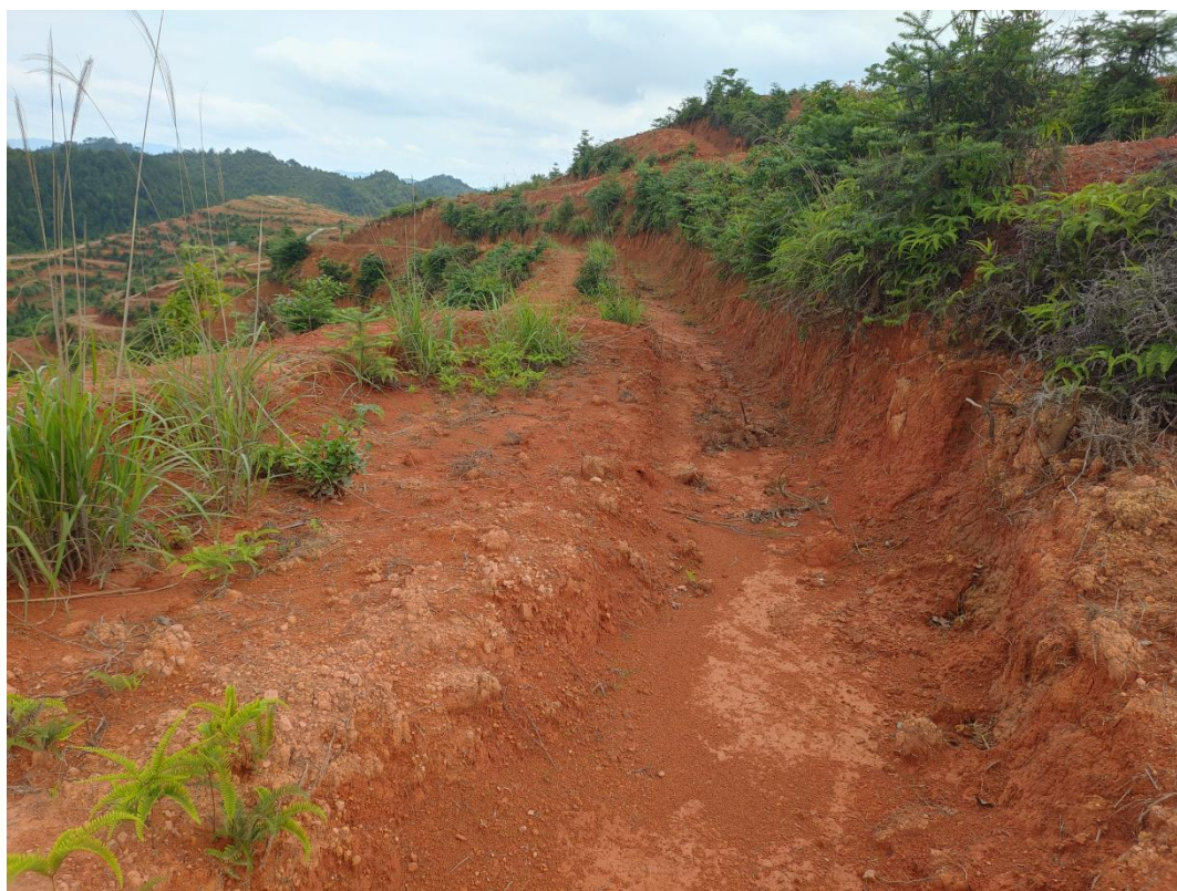
梯田工程区条播植草现状（2021年5月）
