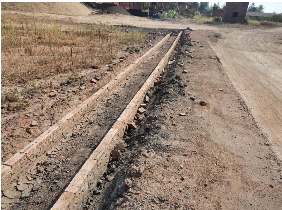
2021年8月现场监测矿山道路区实施情况
