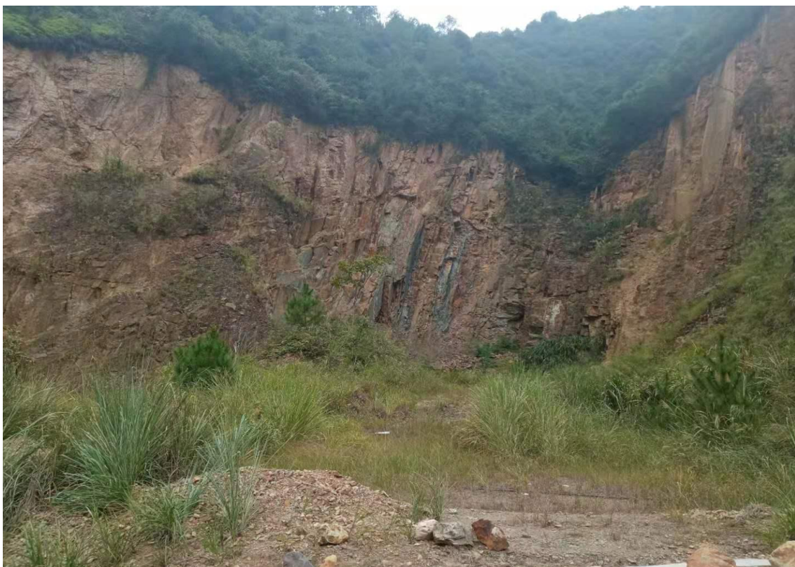
弃渣场植物措施
