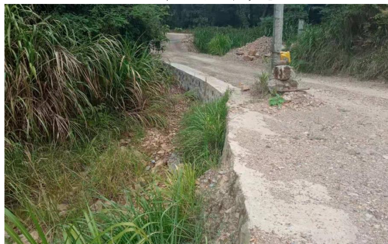
矿区道路排水措施
