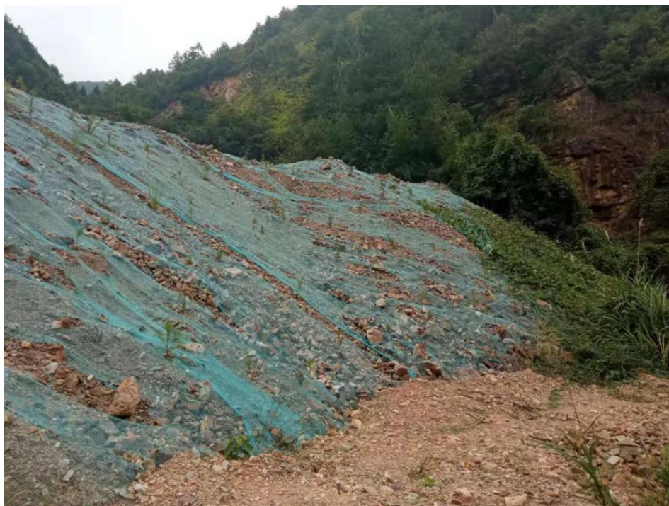
生产生活区临时措施
