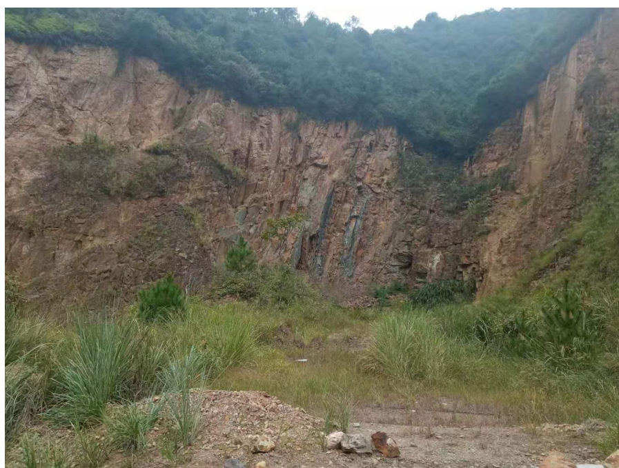
现场监测弃渣场区域实施情况
