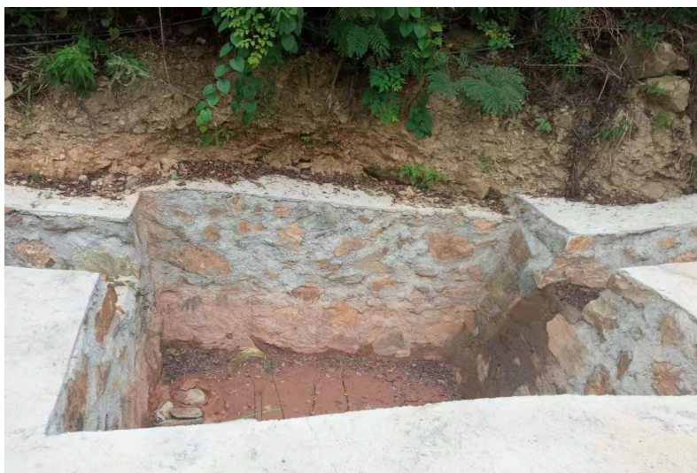
生产生活区沉沙池
