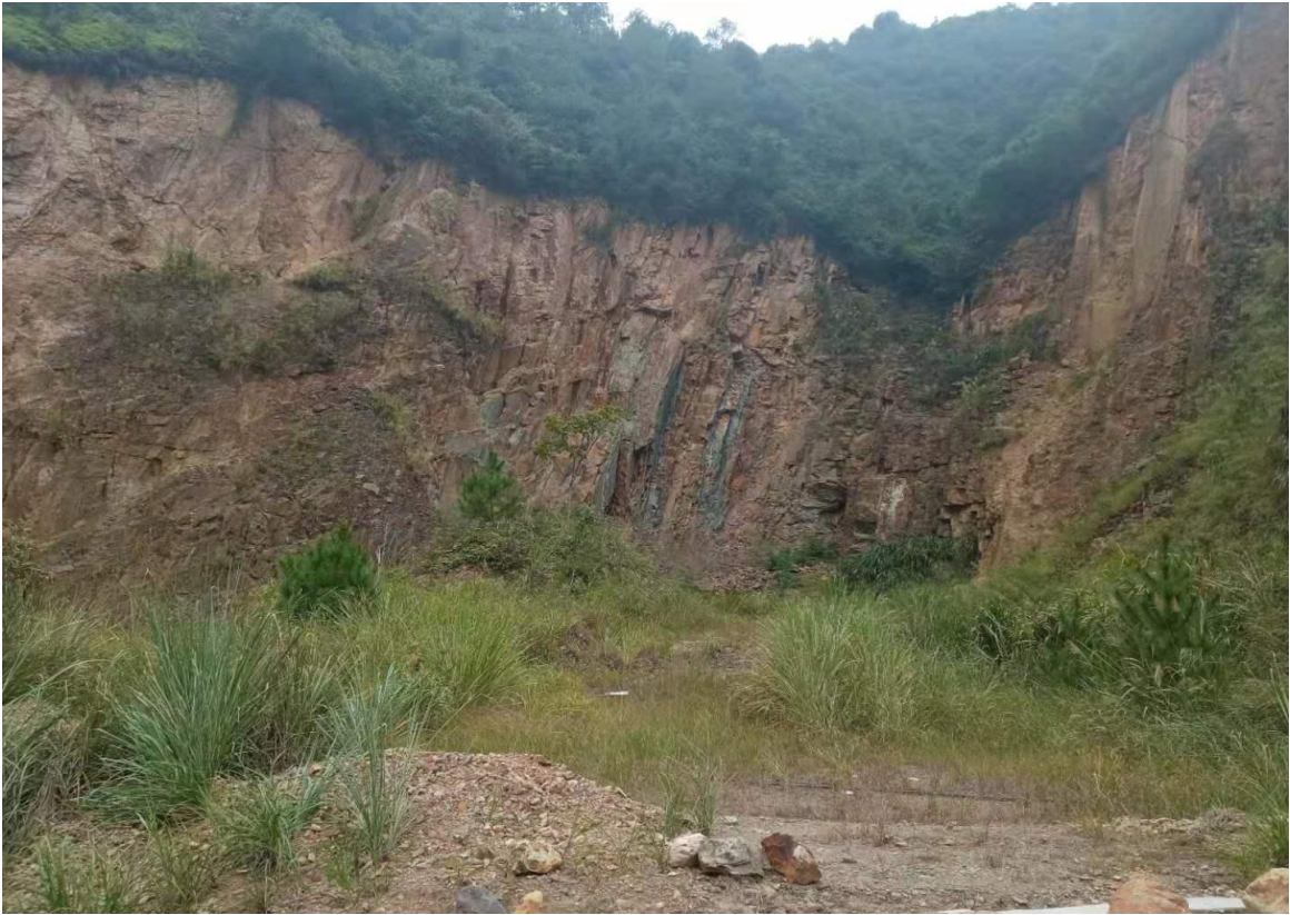
弃渣场植物措施（2021年8月）
