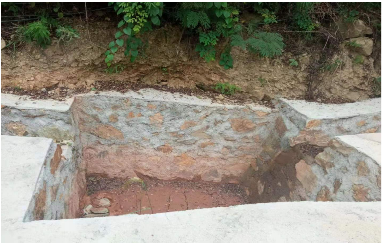
采矿场区沉沙池 (2021年8月)
