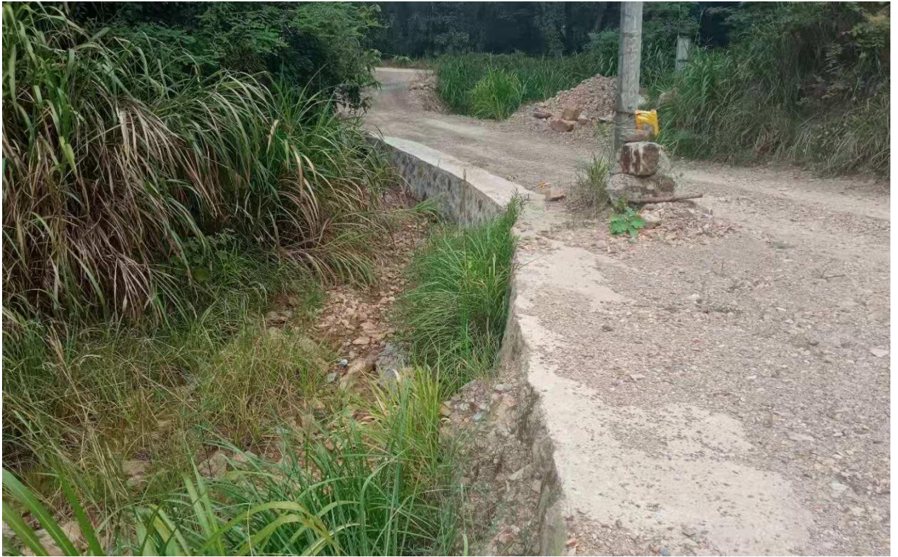
矿区道路排水措施（2021年8月）
