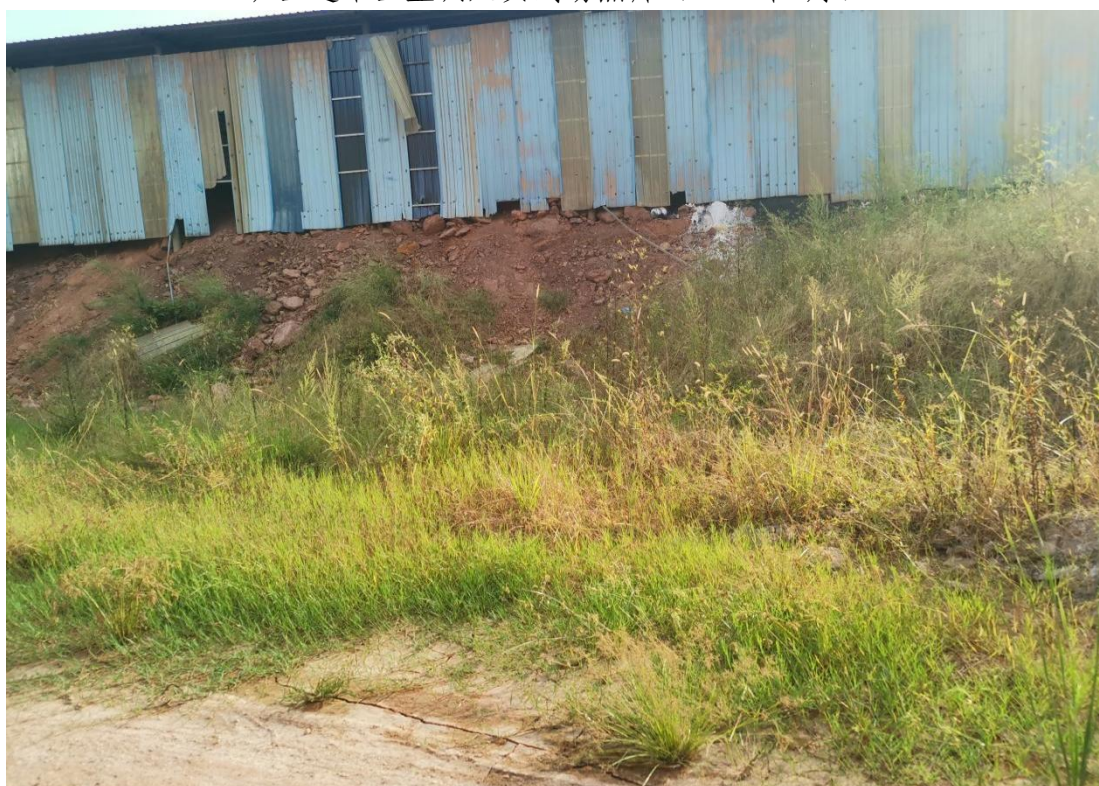
生产设施区植物措施（2021年8月）
