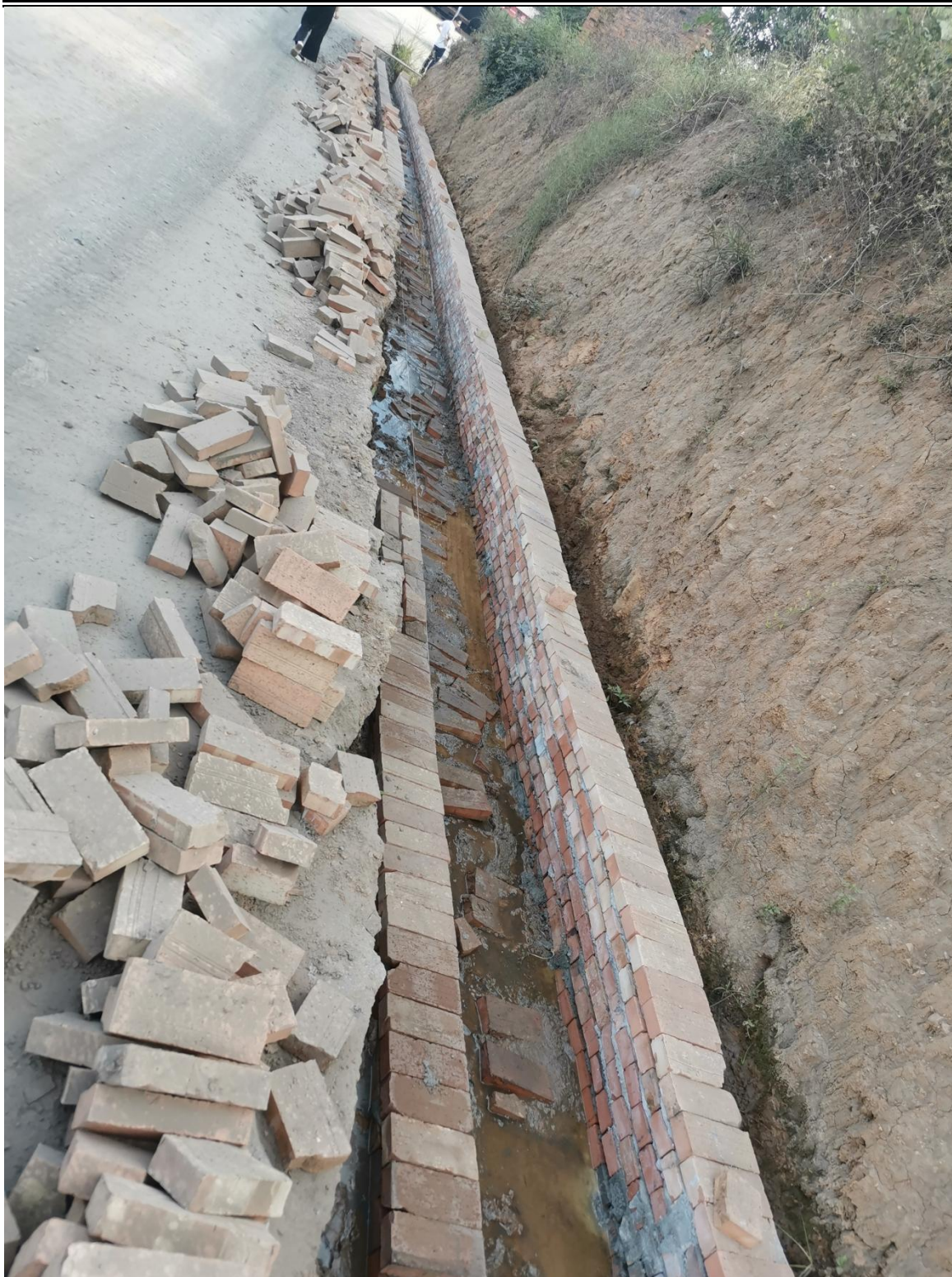
2021年8月现场排水措施实施情况（矿区道路区）
