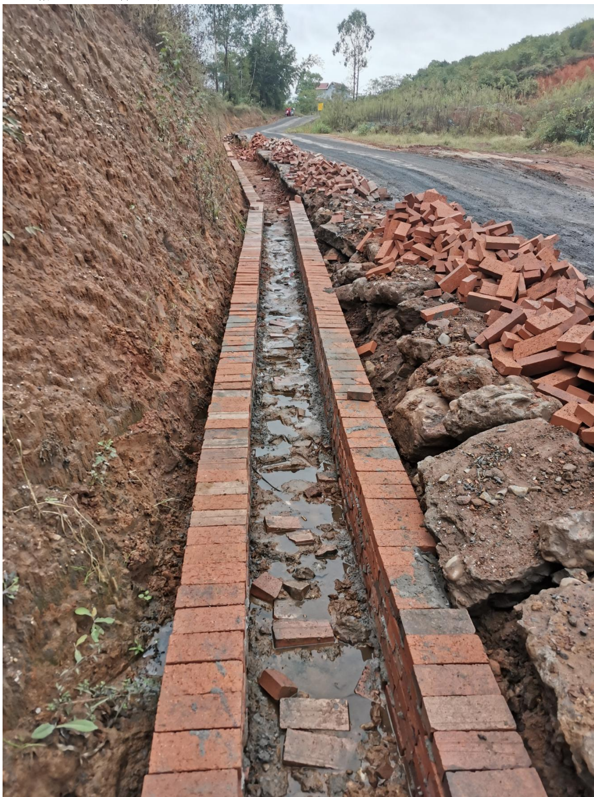
矿区道路区工程措施（2021年9月）
