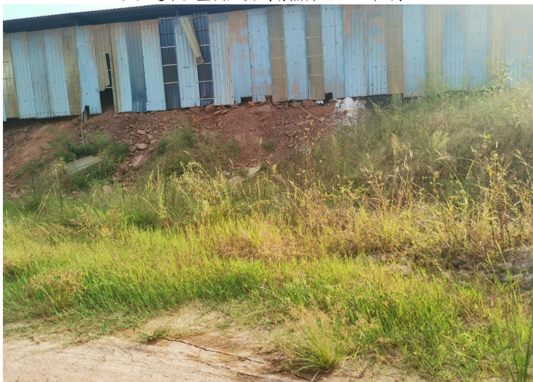
生产设施区植物措施 (2021年8月)
