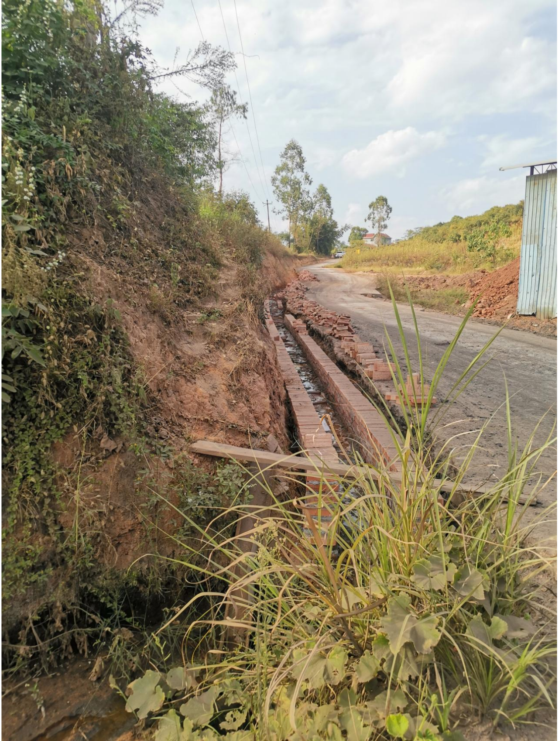
矿区道路区工程措施（2021年8月）
