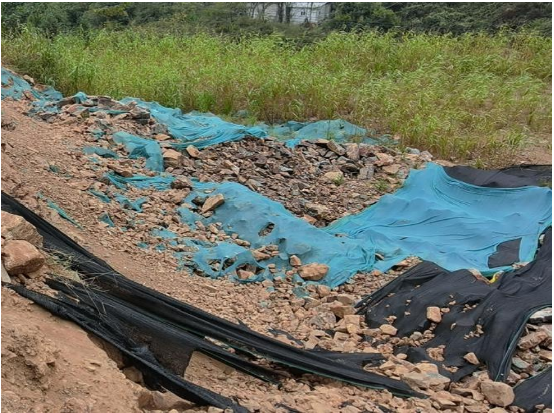
弃渣场临时措施（2021年9月）
