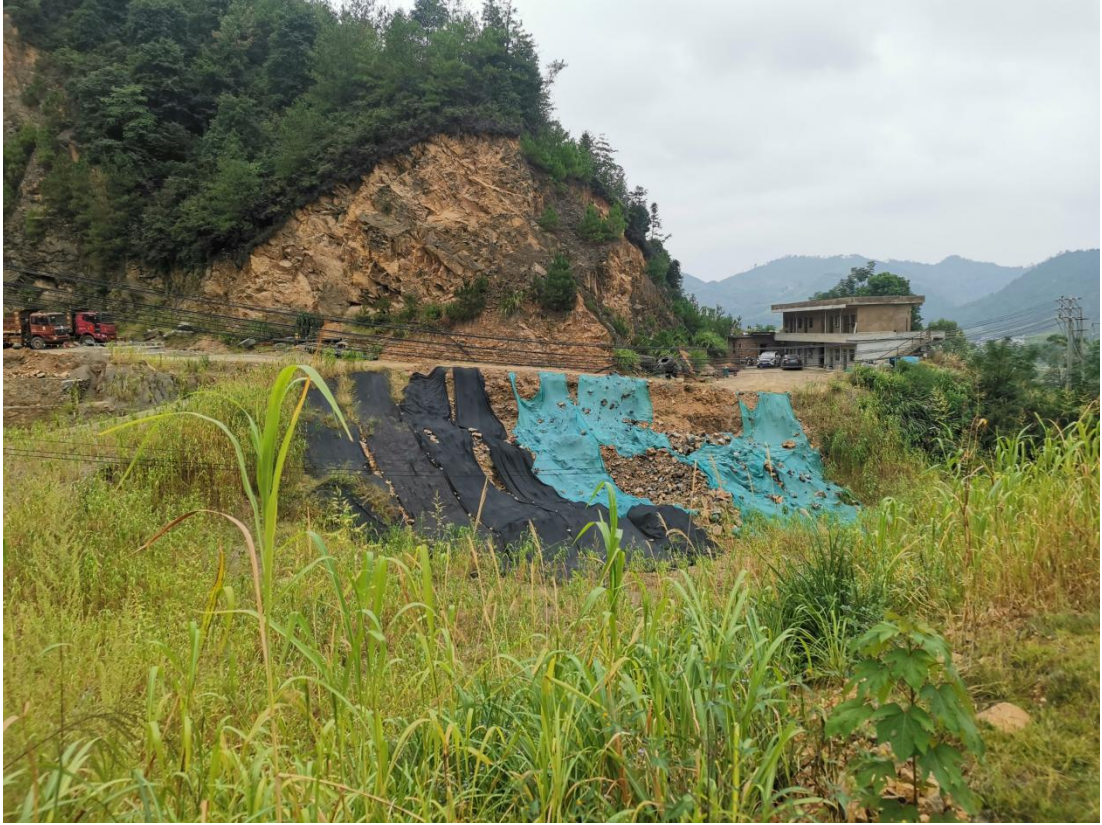
弃渣场临时措施（2021年8月）
