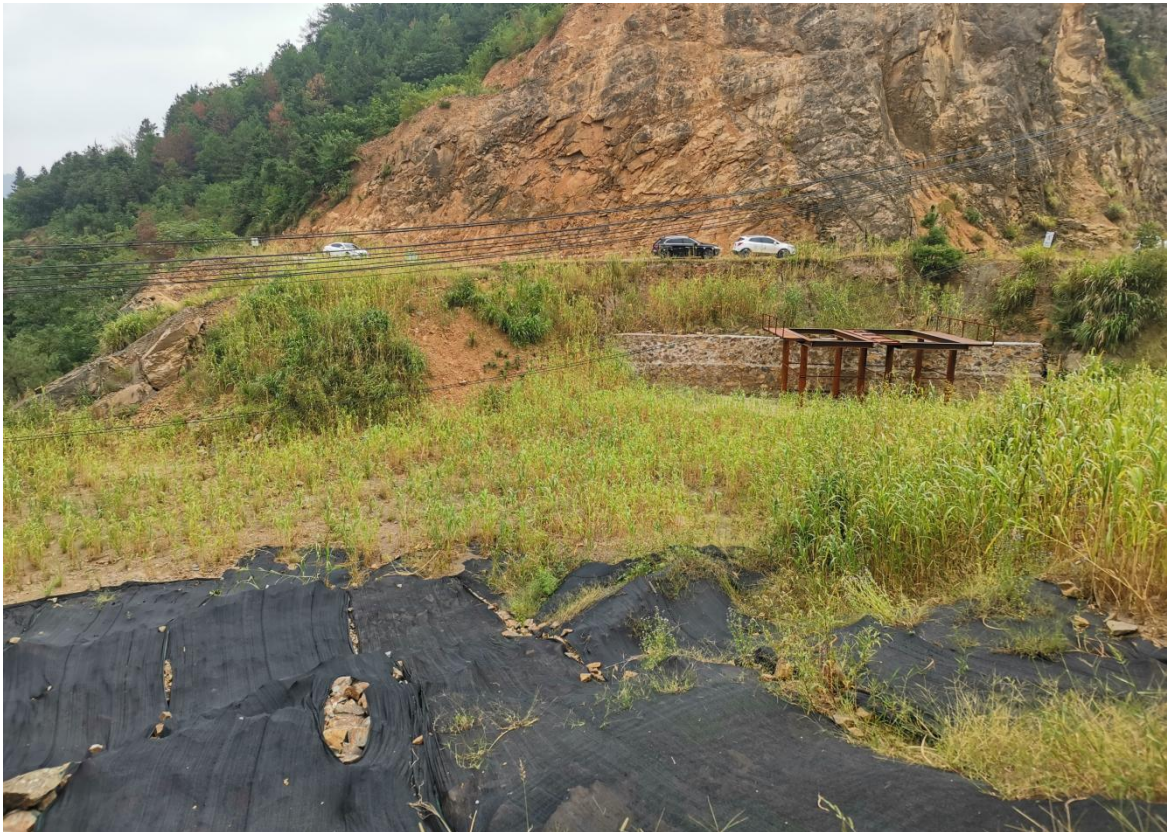
弃渣场临时措施（2021年8月）
