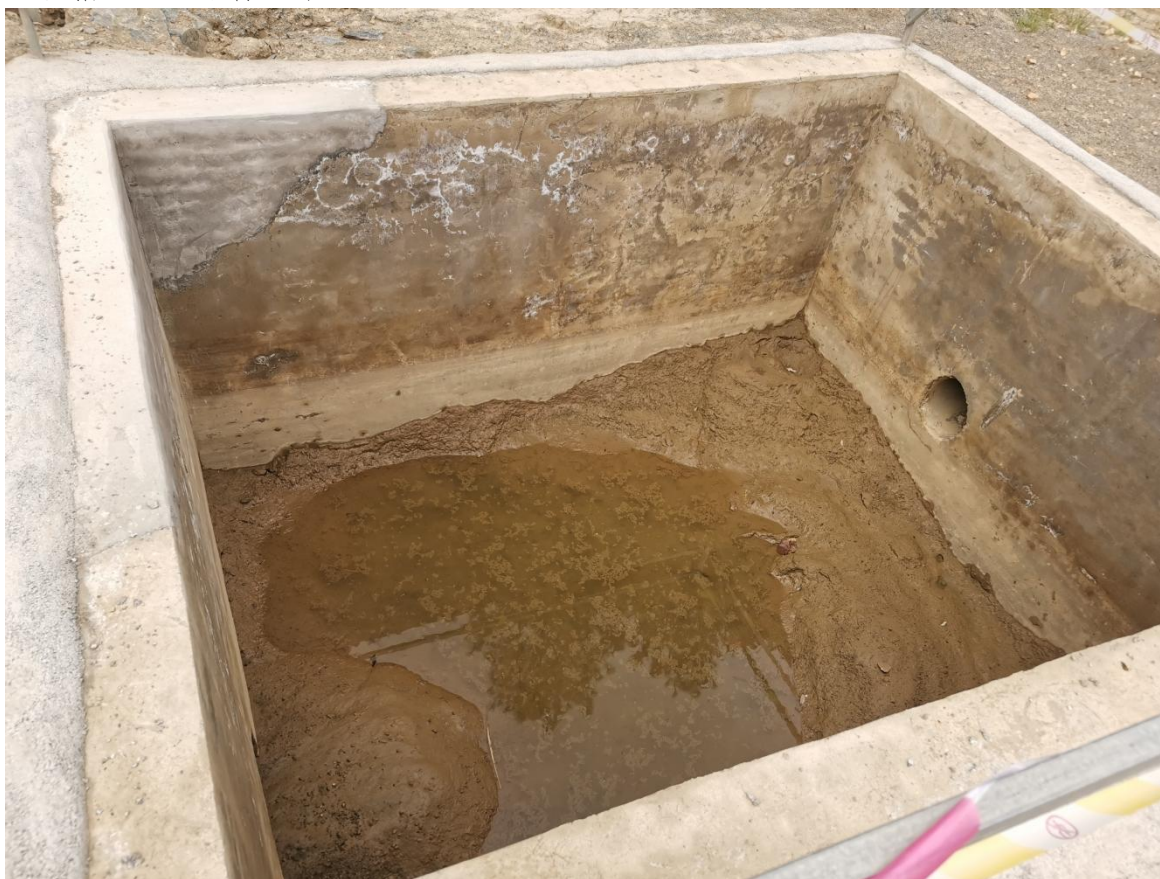
弃渣场工程措施（2021年8月）
