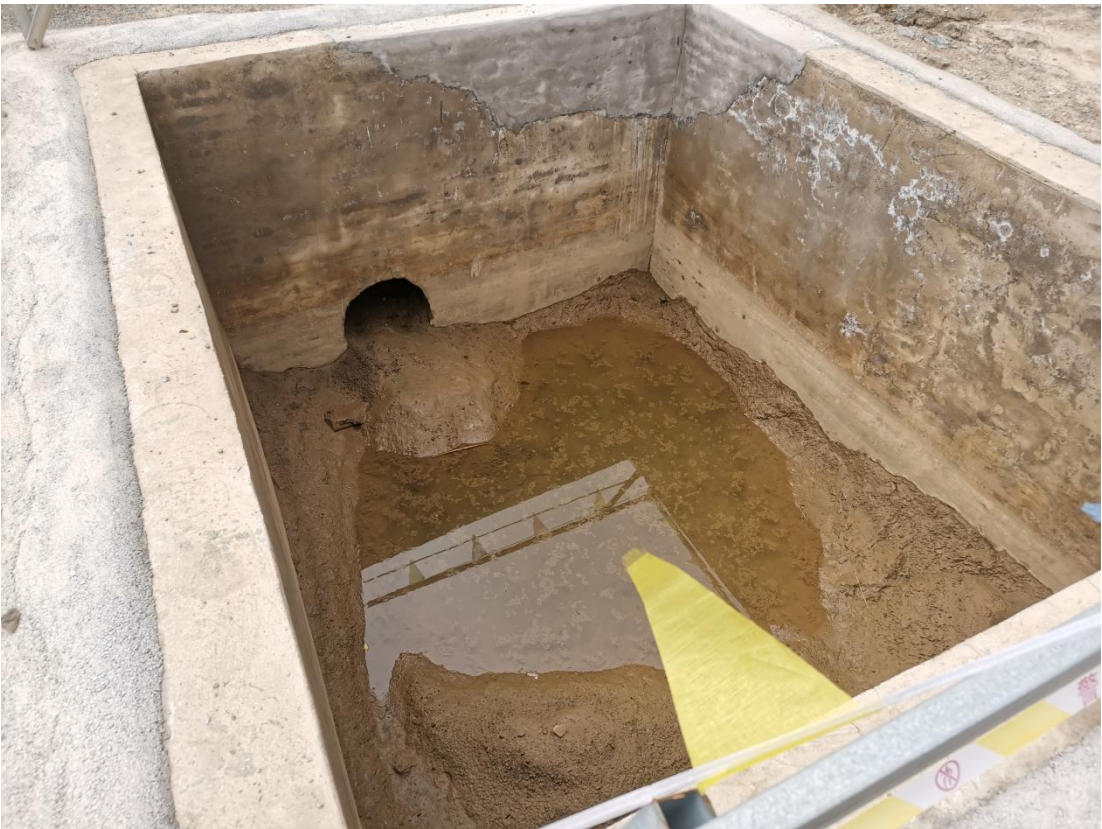
弃渣场工程措施（2021年8月）
