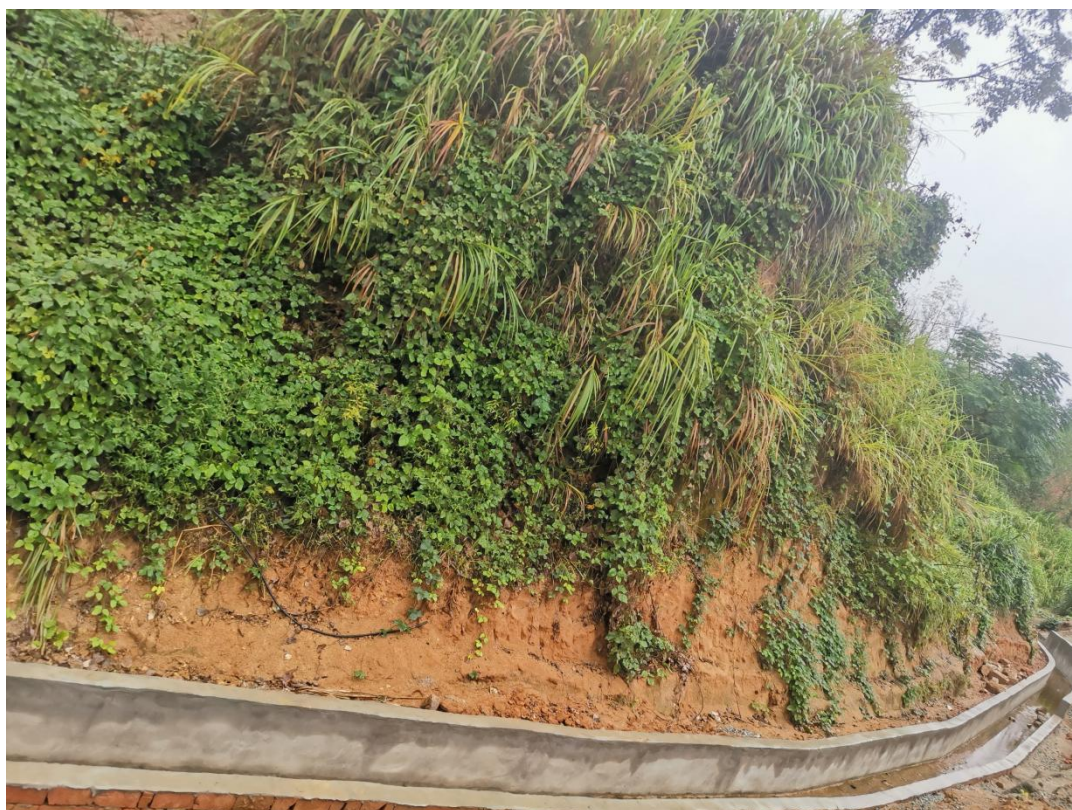
生产加工区工程措施（2021年9月）
