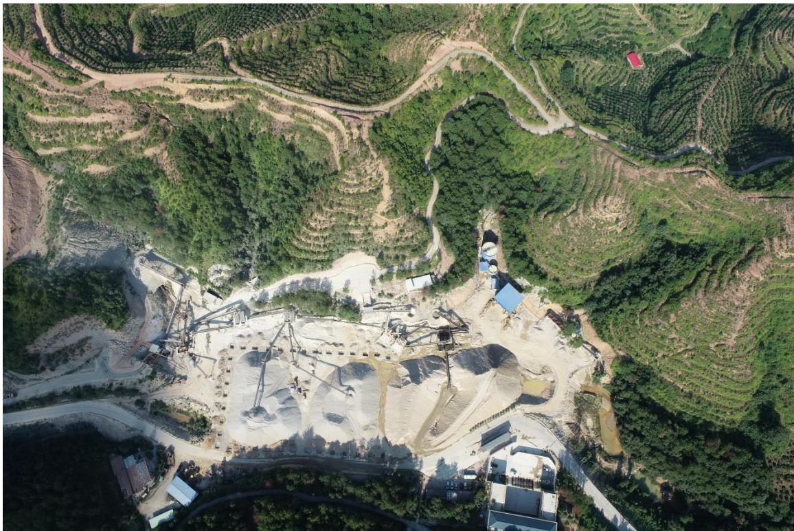
2021年8月现场监测生产加工区实施情况
