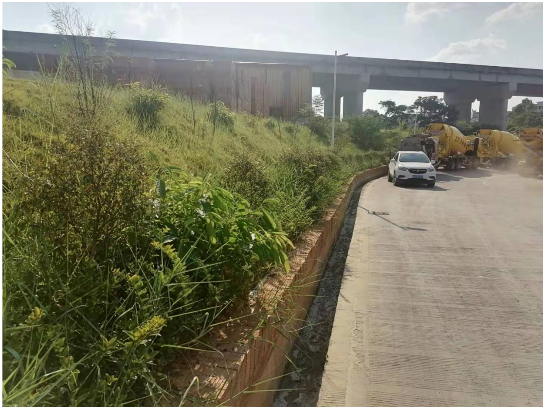
厂区道路区厂区绿化措施（2021年8月）
