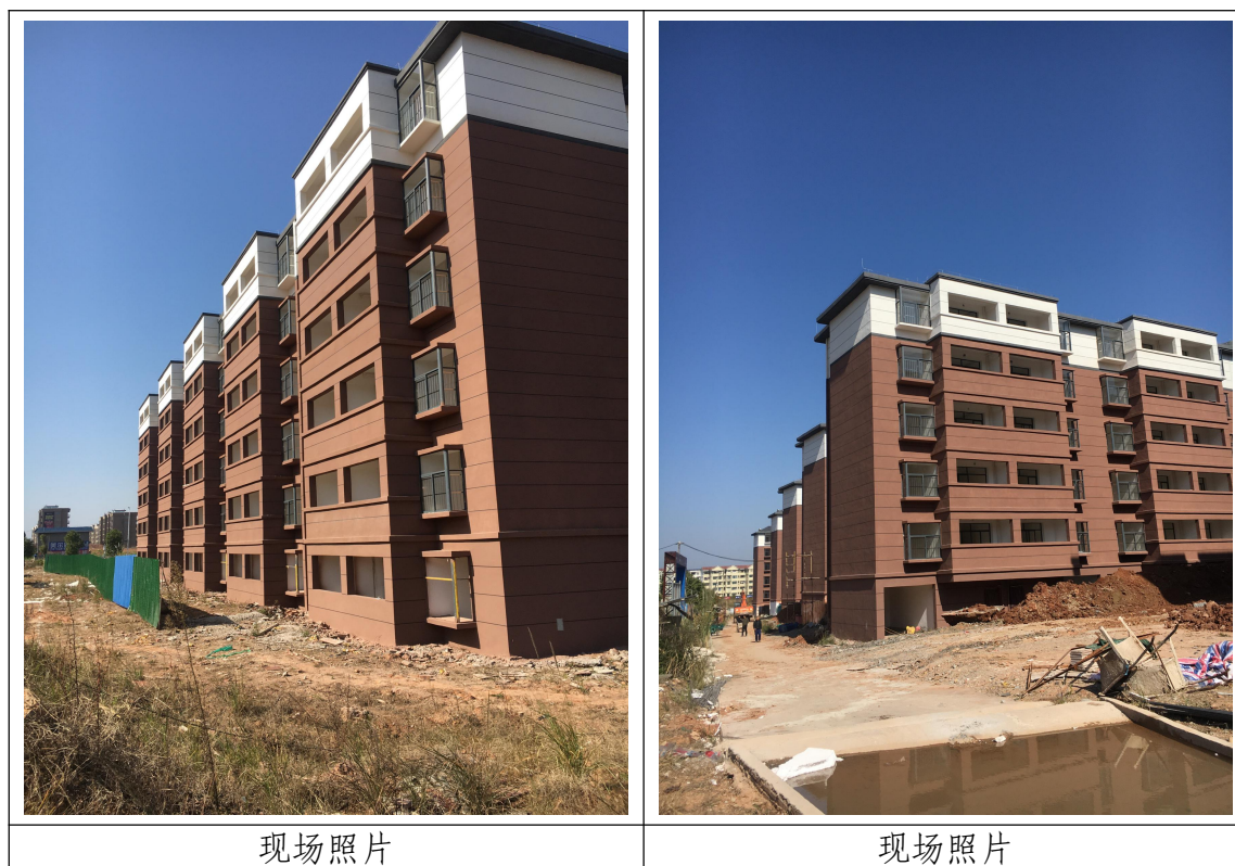
图 1-1 项目区现场照片
