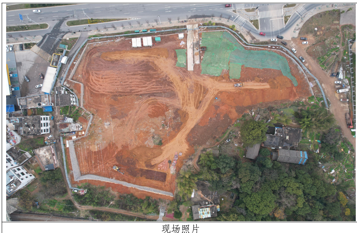
图 1-1 项目区现场照片
