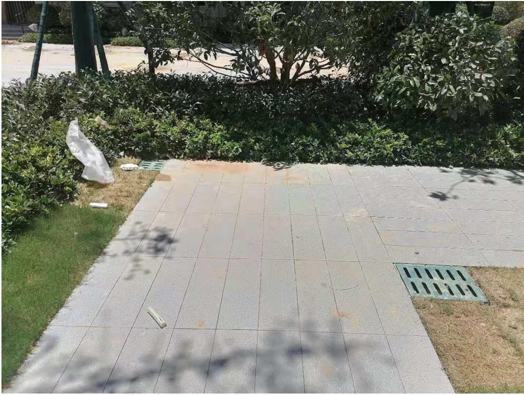
景观绿化区排水工程措施（2021年9月）
