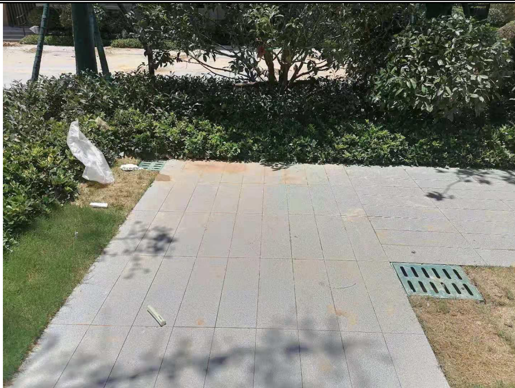
2021年9月现场景观绿化区排水措施实施情况
