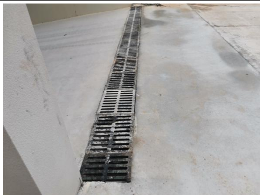
地下室出入口盖板排水沟
