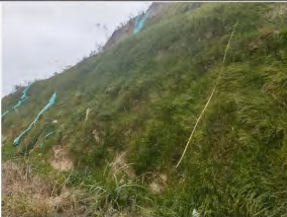
2021年10月现场植物措施实施情况（排土场）
