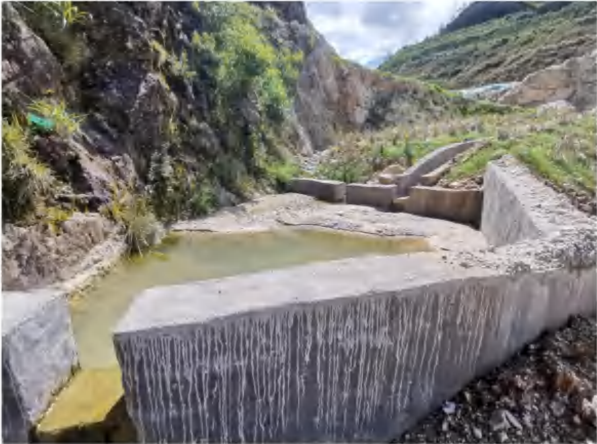
矿山道路工程措施（2022年6月）
