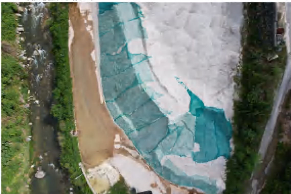
破碎场临时措施（2022年6月）
