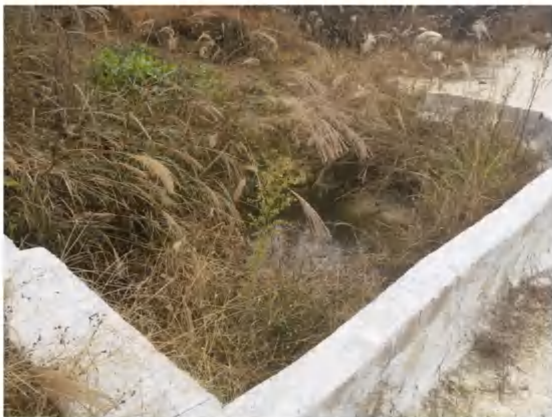
矿山道路工程措施（2021年10月）
