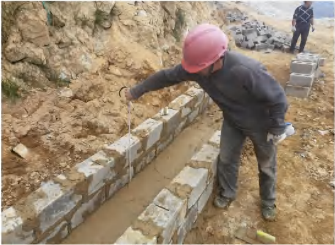
矿山道路现场监测照片（2021年10月）
