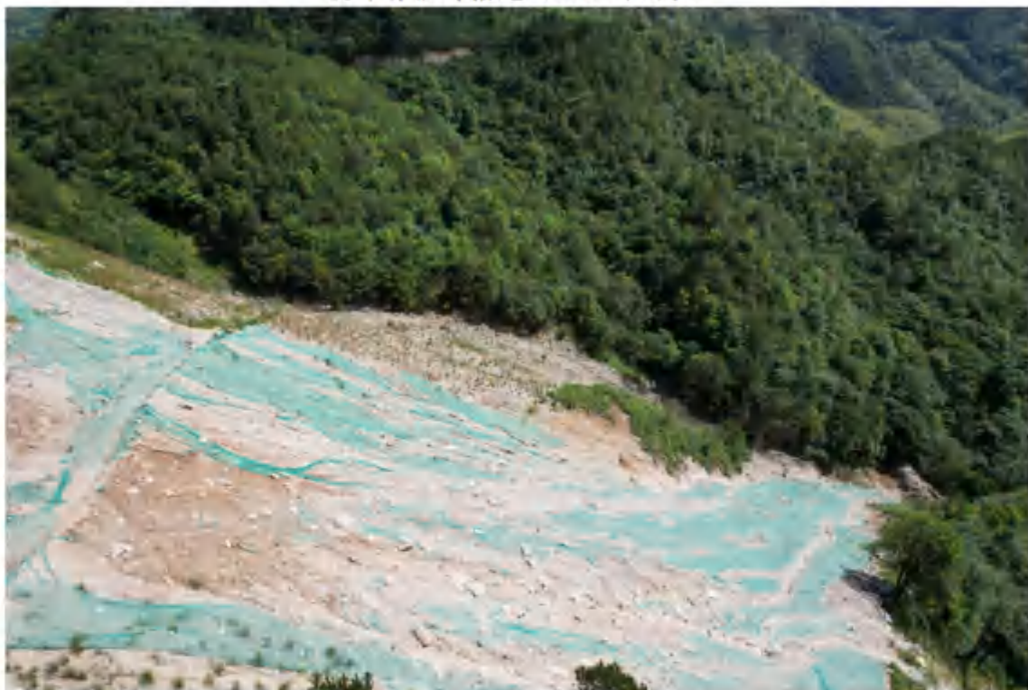
排土场临时措施（2022年6月）
