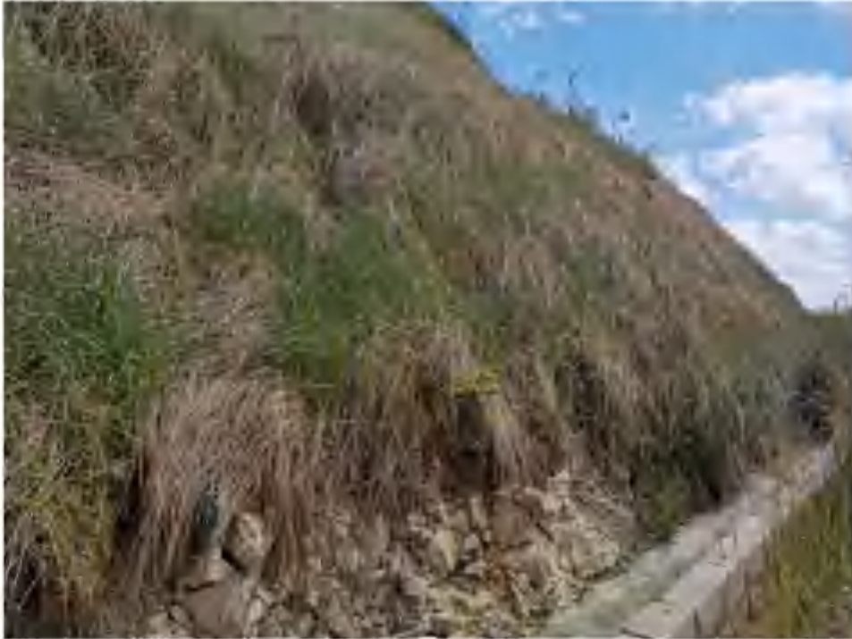
排土场植物措施（2022年6月）
