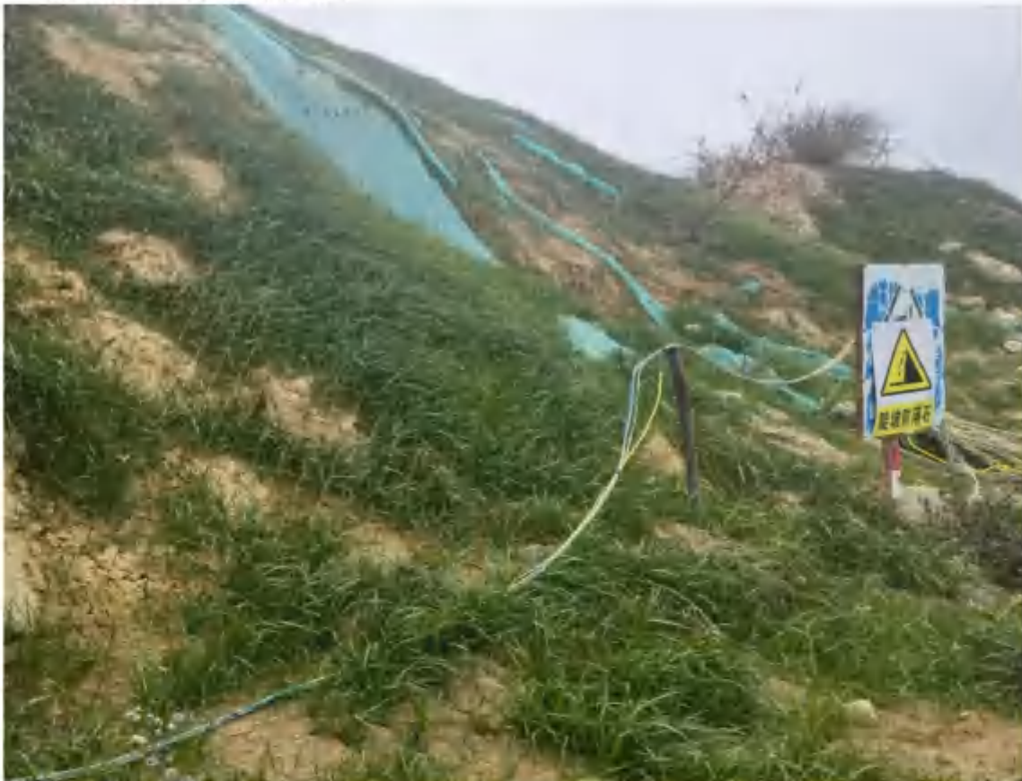
排土场植物措施（2021年10月）
