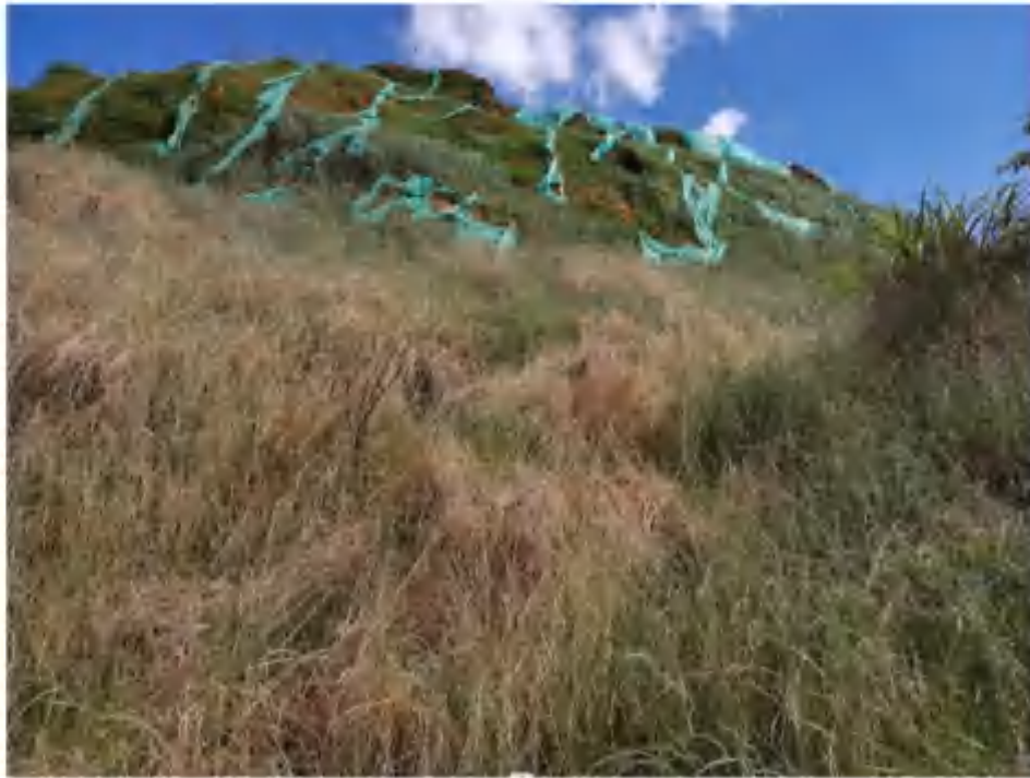
排土场植物措施（2022年6月）
