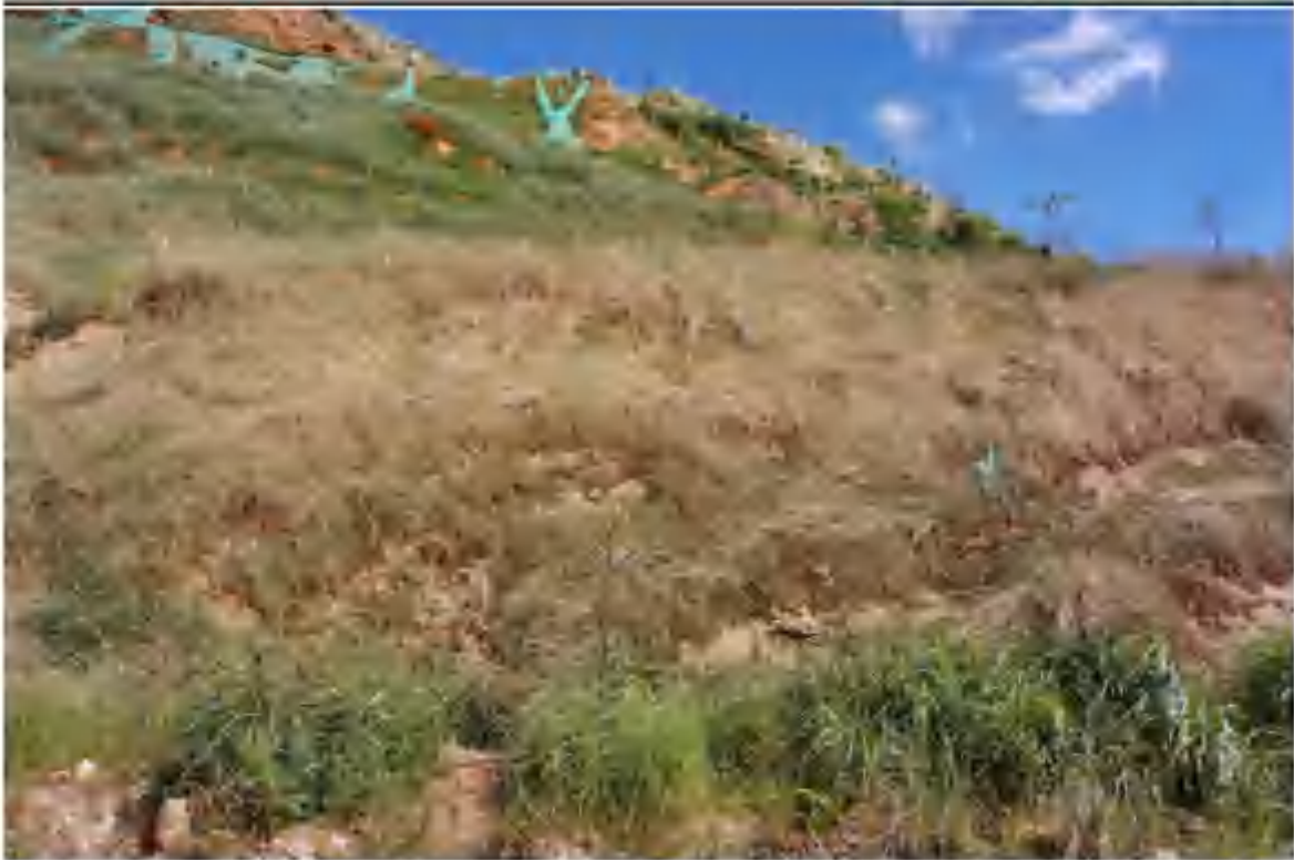
排土场植物措施（2022年6月）
