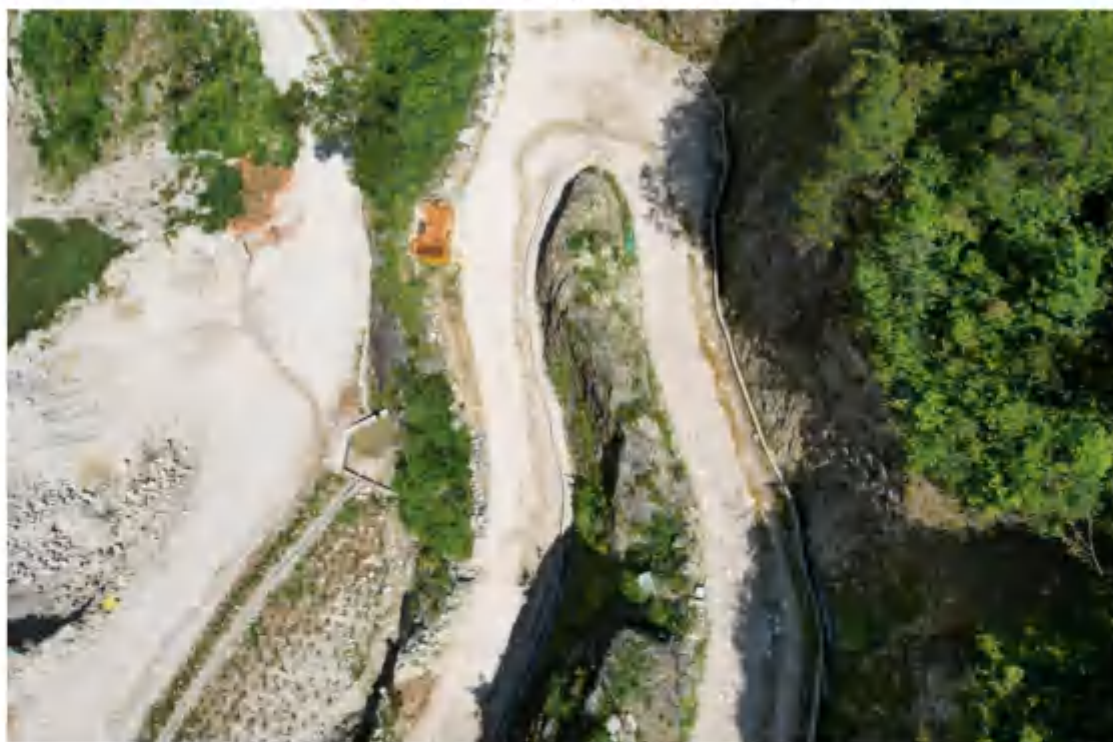
矿山道路工程措施（2022年6月）
