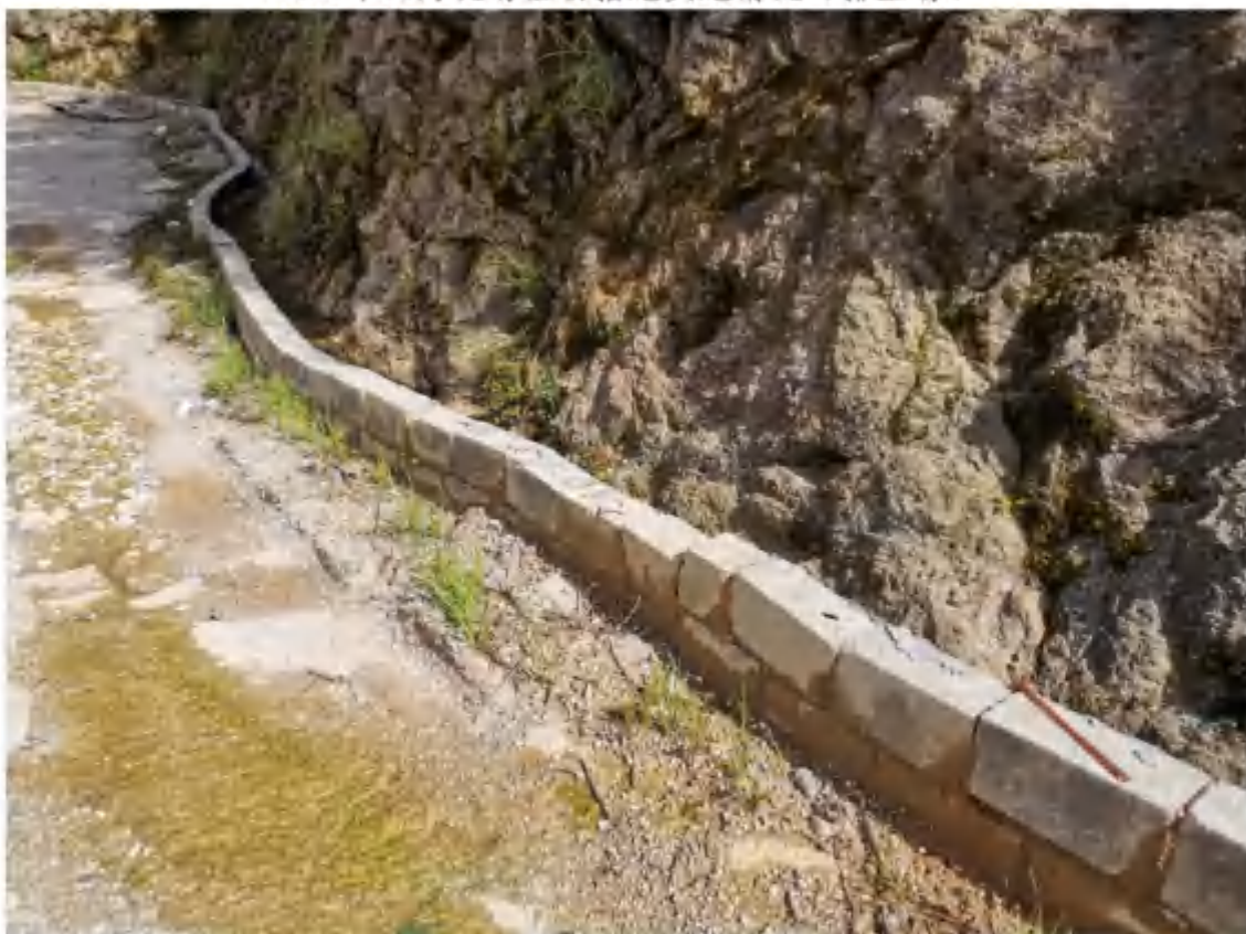
2022年6月现场排水措施实施情况（矿山道路）
