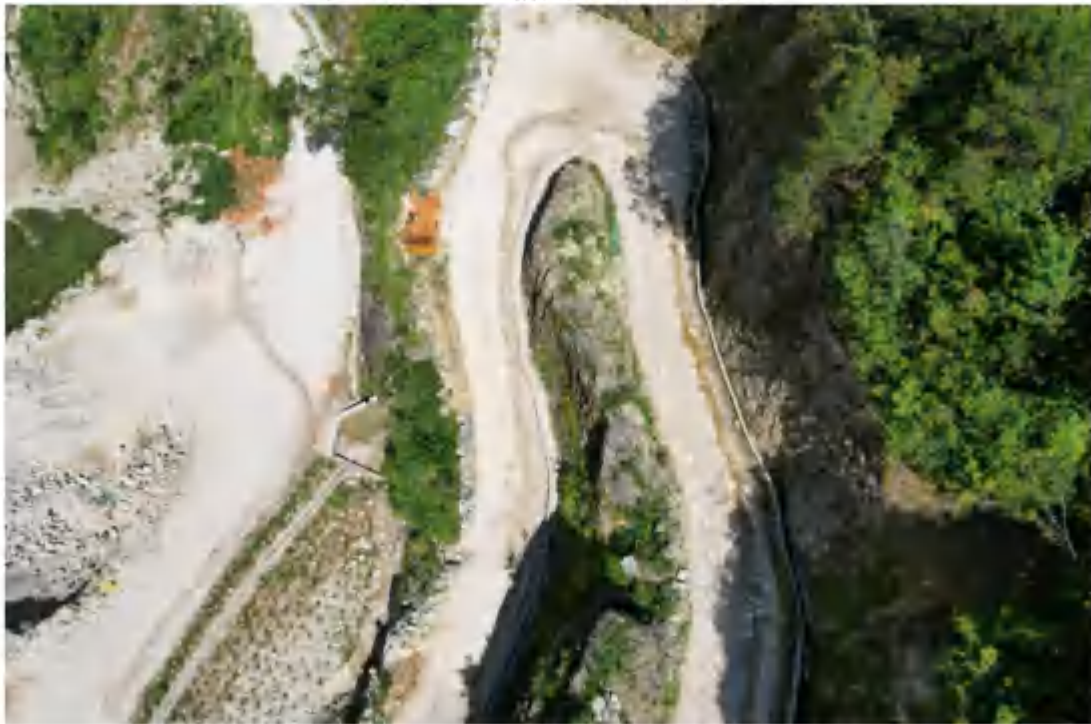
矿山道路工程措施（2022年6月）
