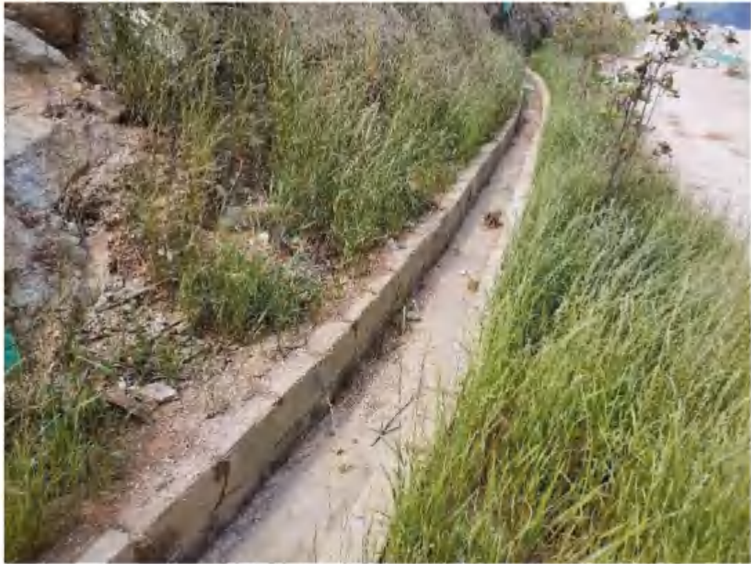
矿山道路工程措施（2022年6月）
