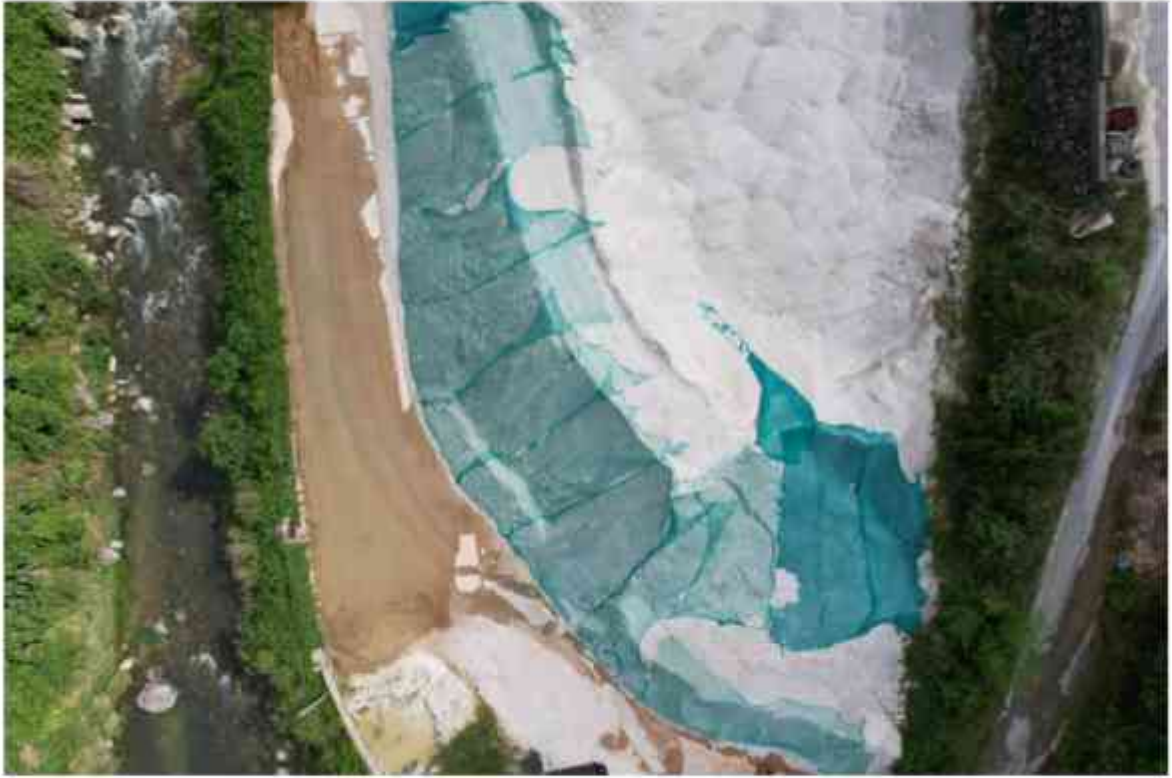
破碎场临时措施（2022年6月）
