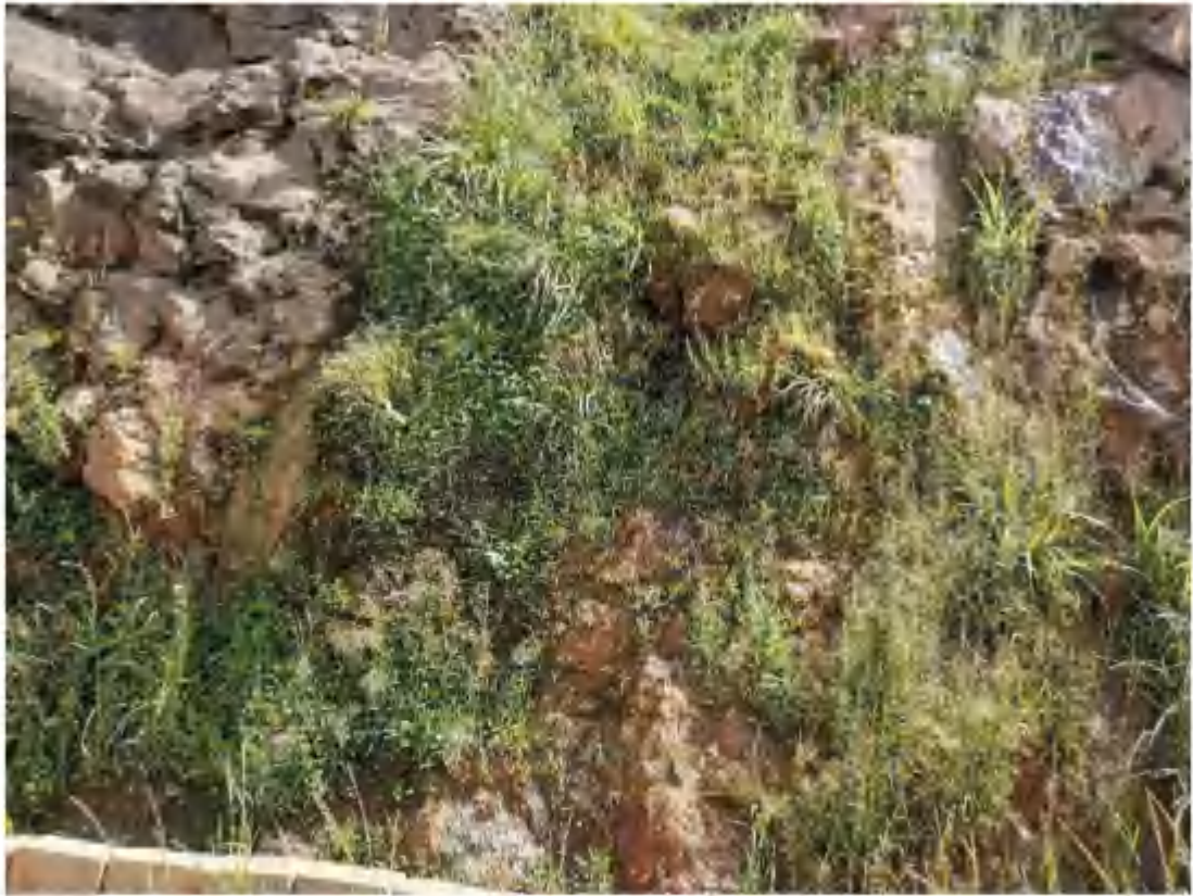
矿山道路工程措施（2022年6月）
