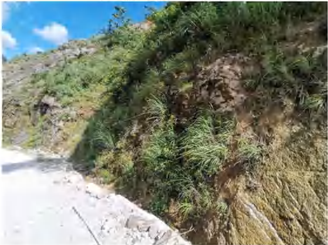
矿山道路工程措施（2022年6月）
