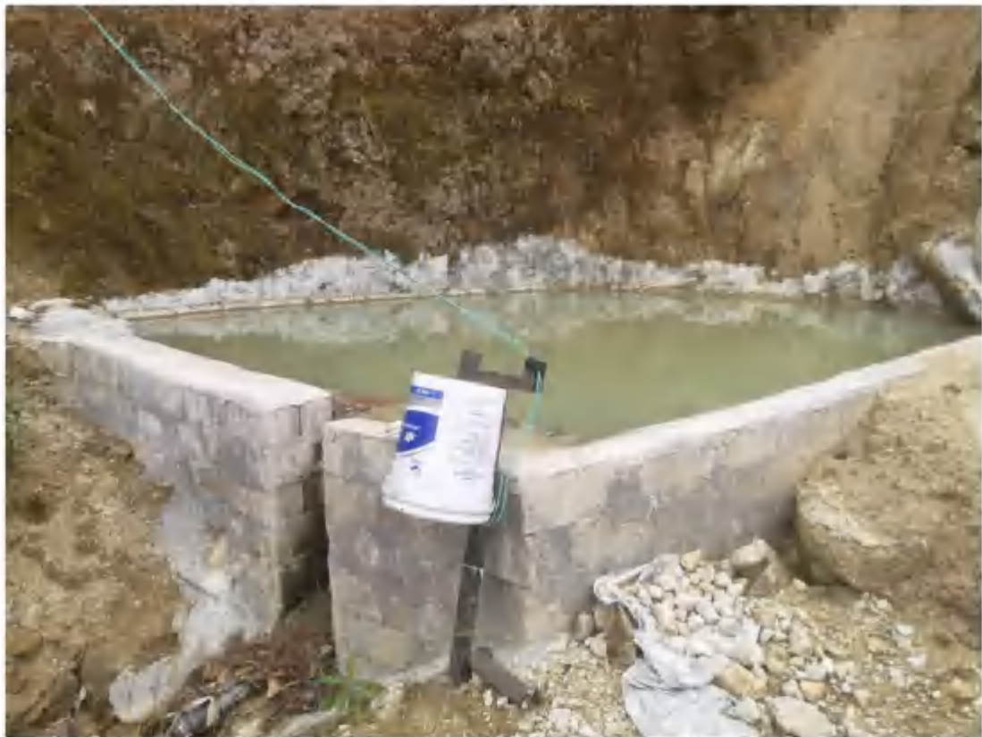
矿山道路工程措施 (2021年10月)
