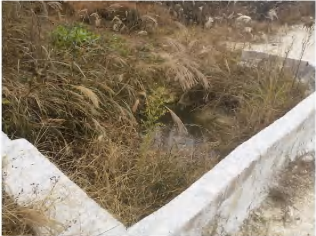
矿山道路工程措施 (2021年10月)
