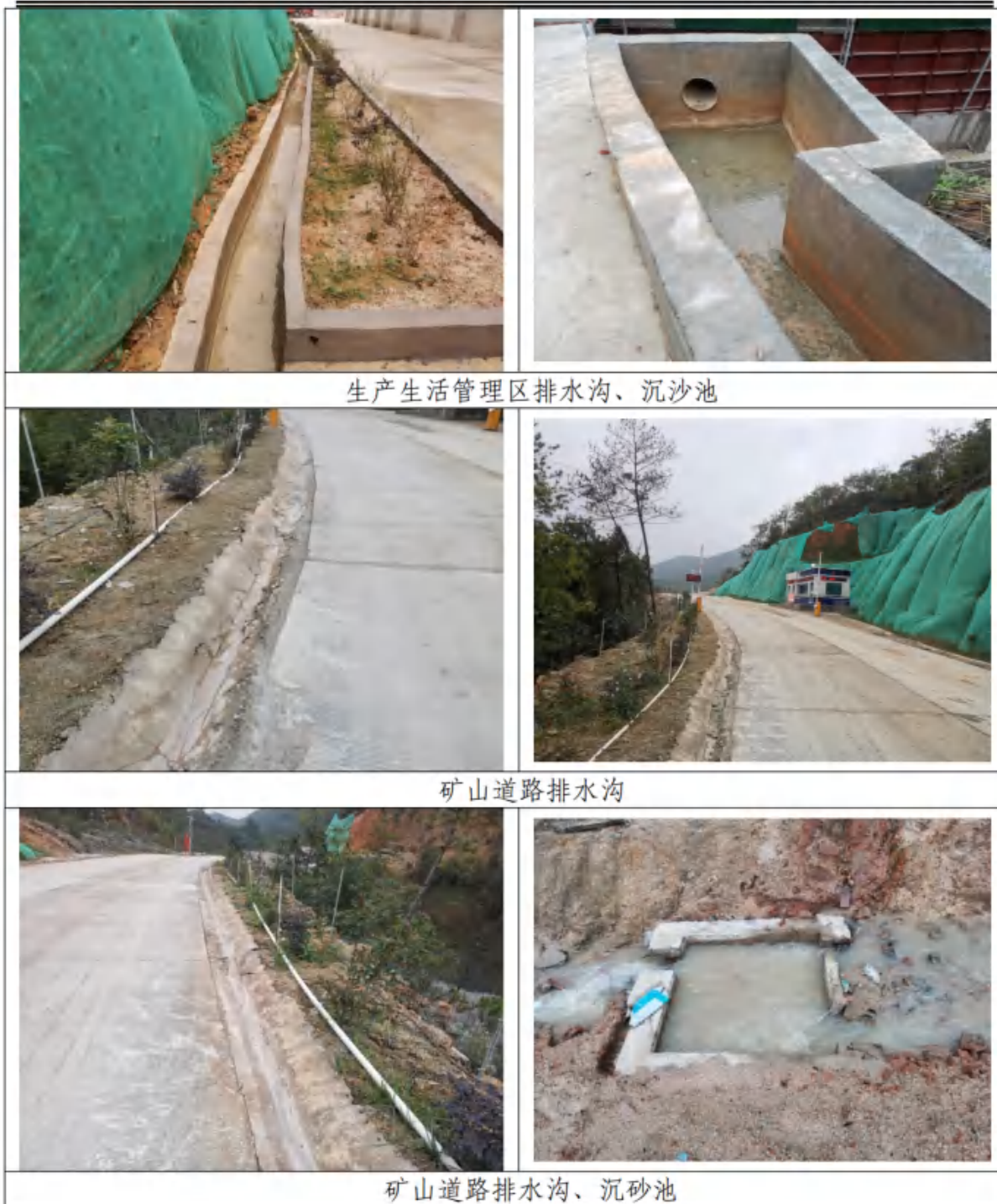
图4-1工程措施照片
