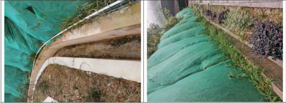
生产生活管理区排水沟
