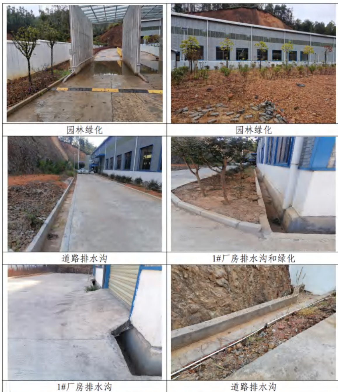
图 2-1 水土保持措施图片
