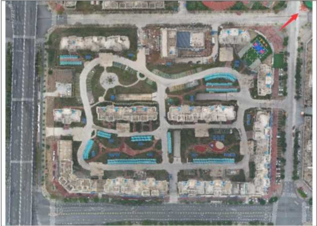
7、项目区现场航拍
