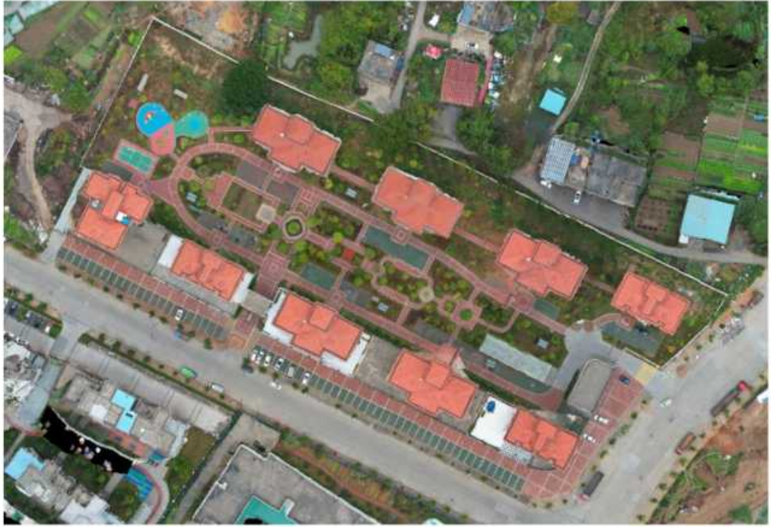
项目整体航拍图
