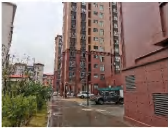
5、铺草坪、栽植乔木、栽植灌木
