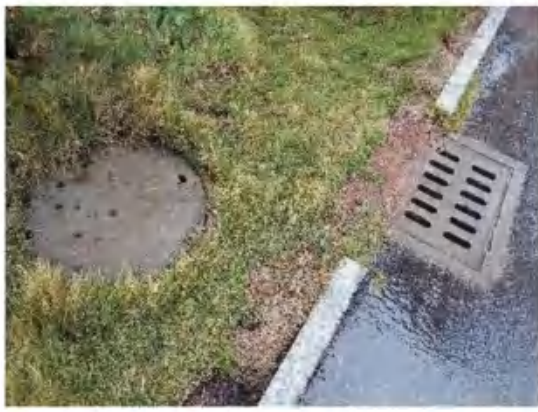
1、雨水口、雨水井、铺草坪
