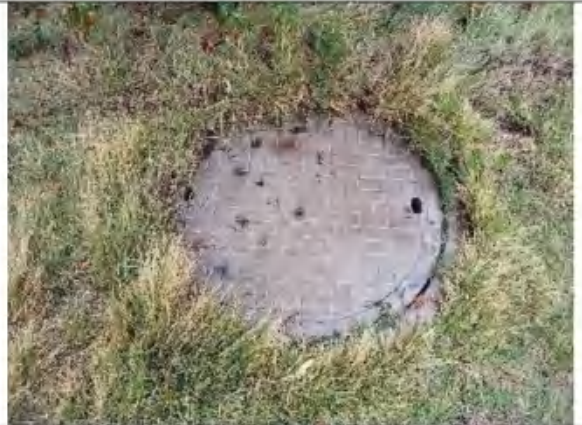
6、雨水井、铺草坪
