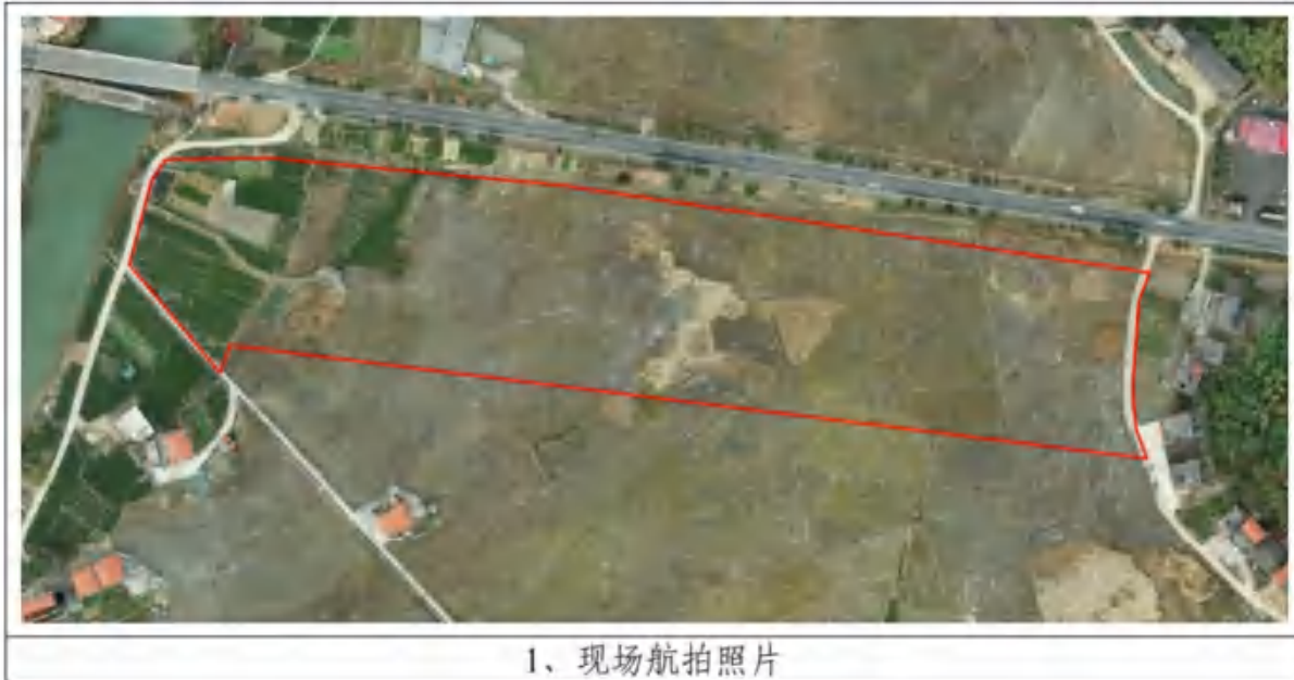
图 1-1 项目区现场航拍照片
