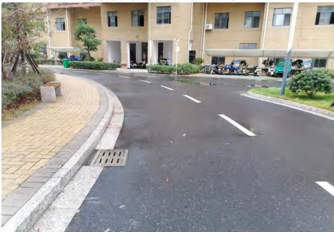
道路广场区排水口（2022年10月）
