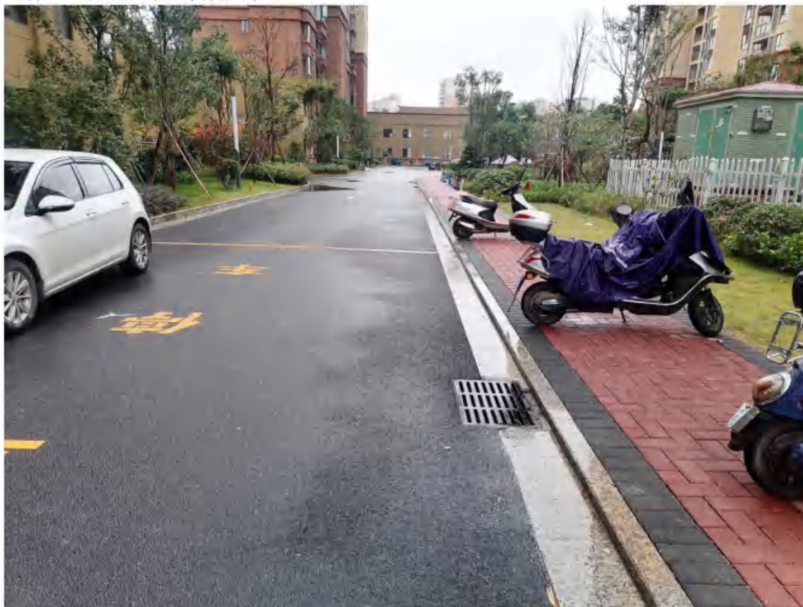
道路广场区降雨蓄渗和雨水口（2022年10月）
