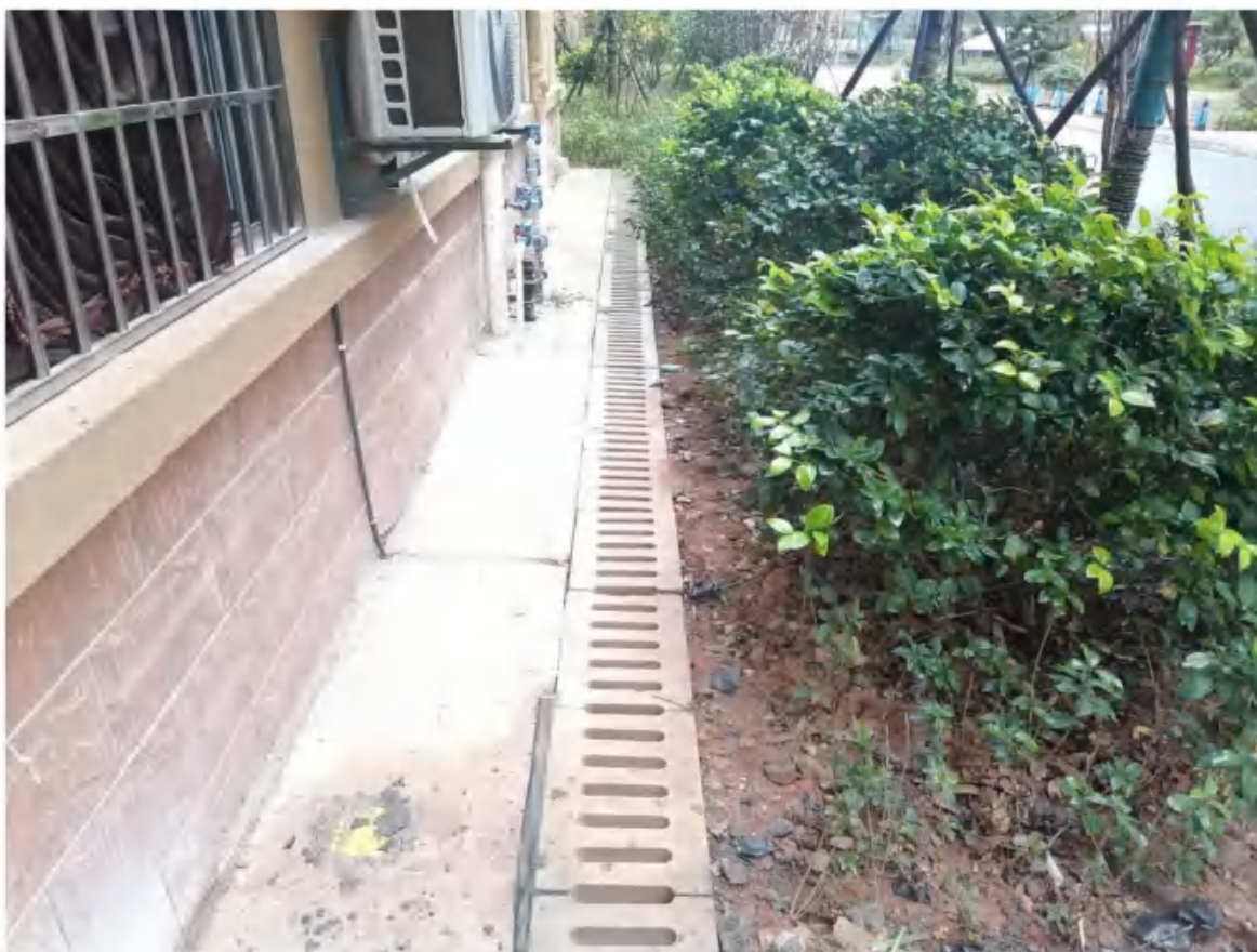
盖板排水沟和景观绿化（2022年10月）
