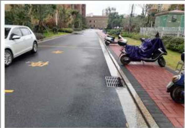
道路广场区雨水口和透水铺装
