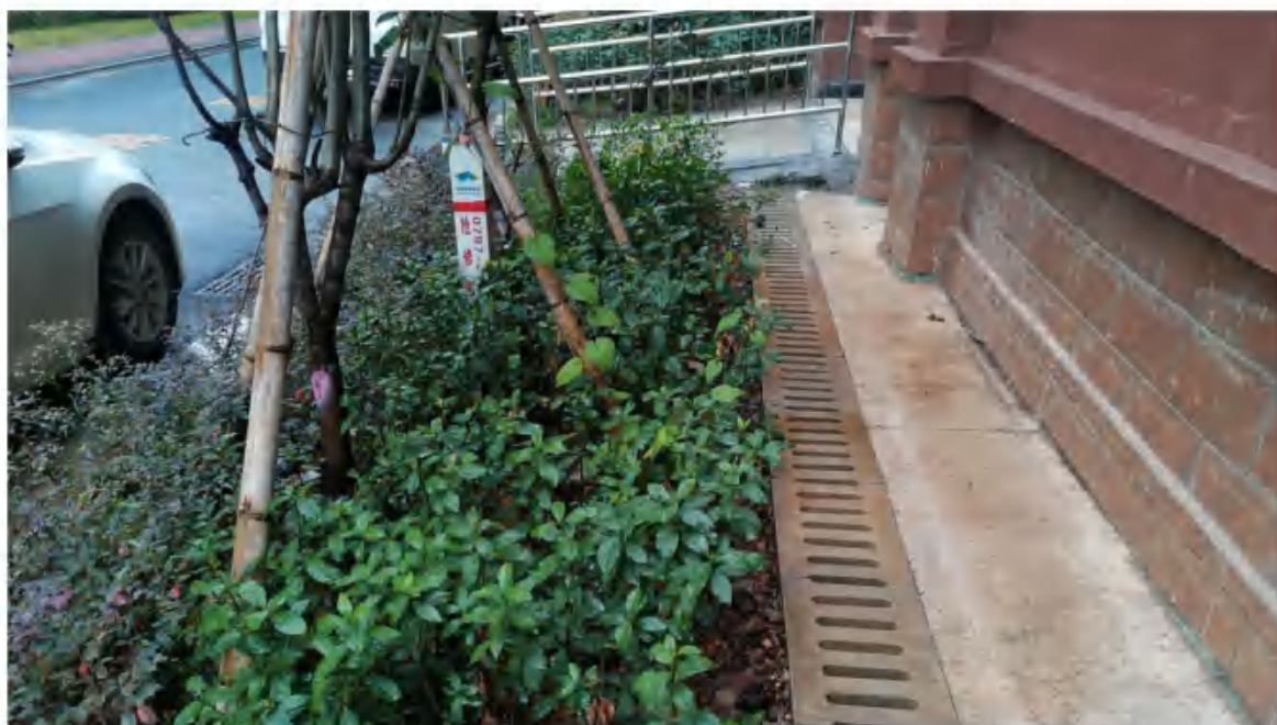
建筑物区盖板排水沟和景观绿化绿化（2022年10月）
