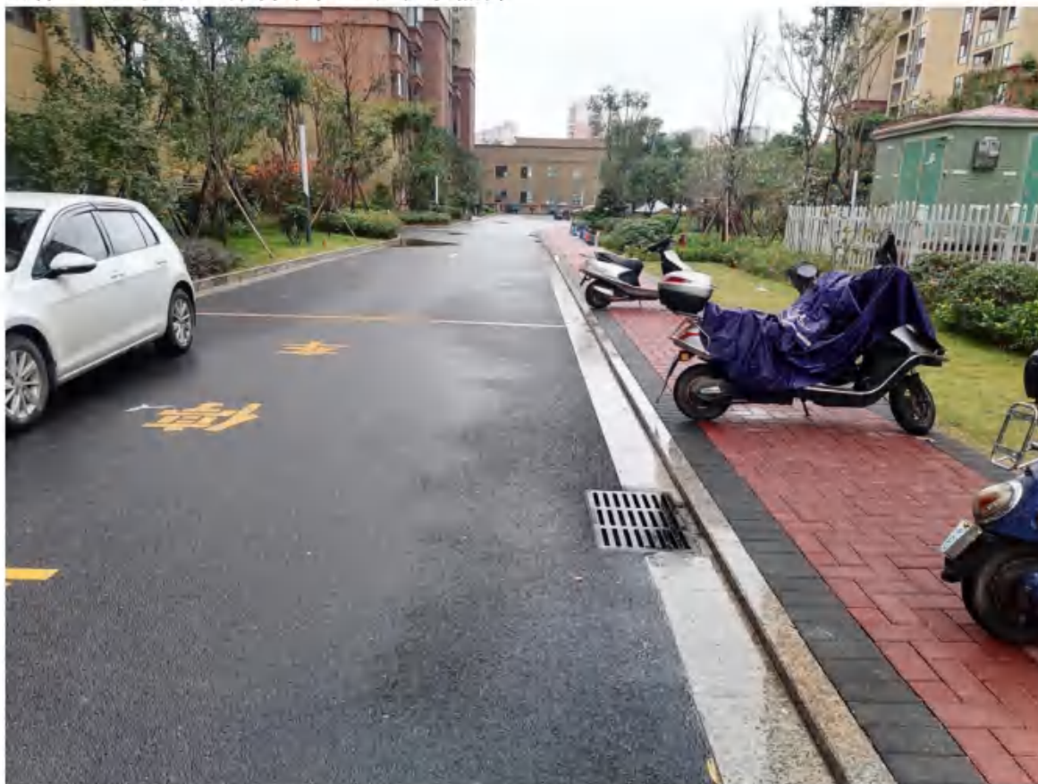
道路广场区降雨蓄渗和雨水口 (2022年10月)
