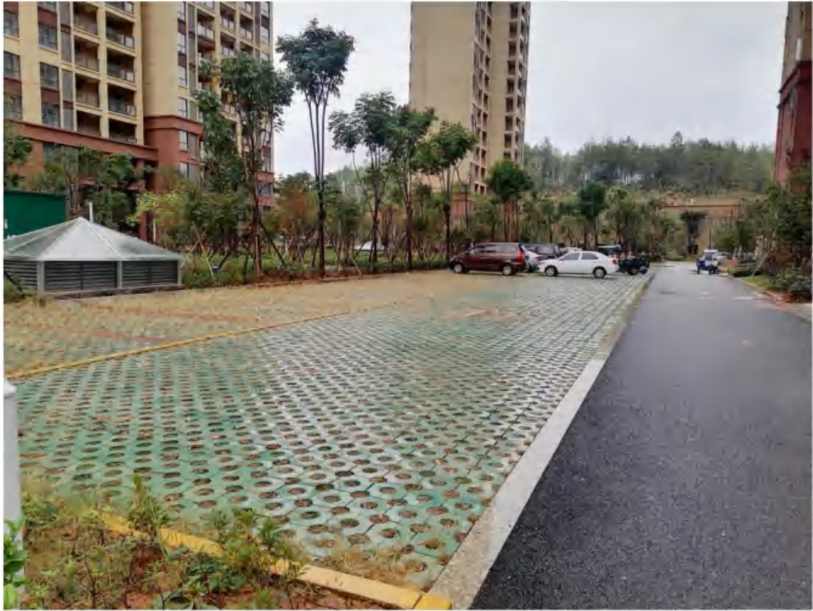
道路广场区降雨蓄渗（2022年10月）
