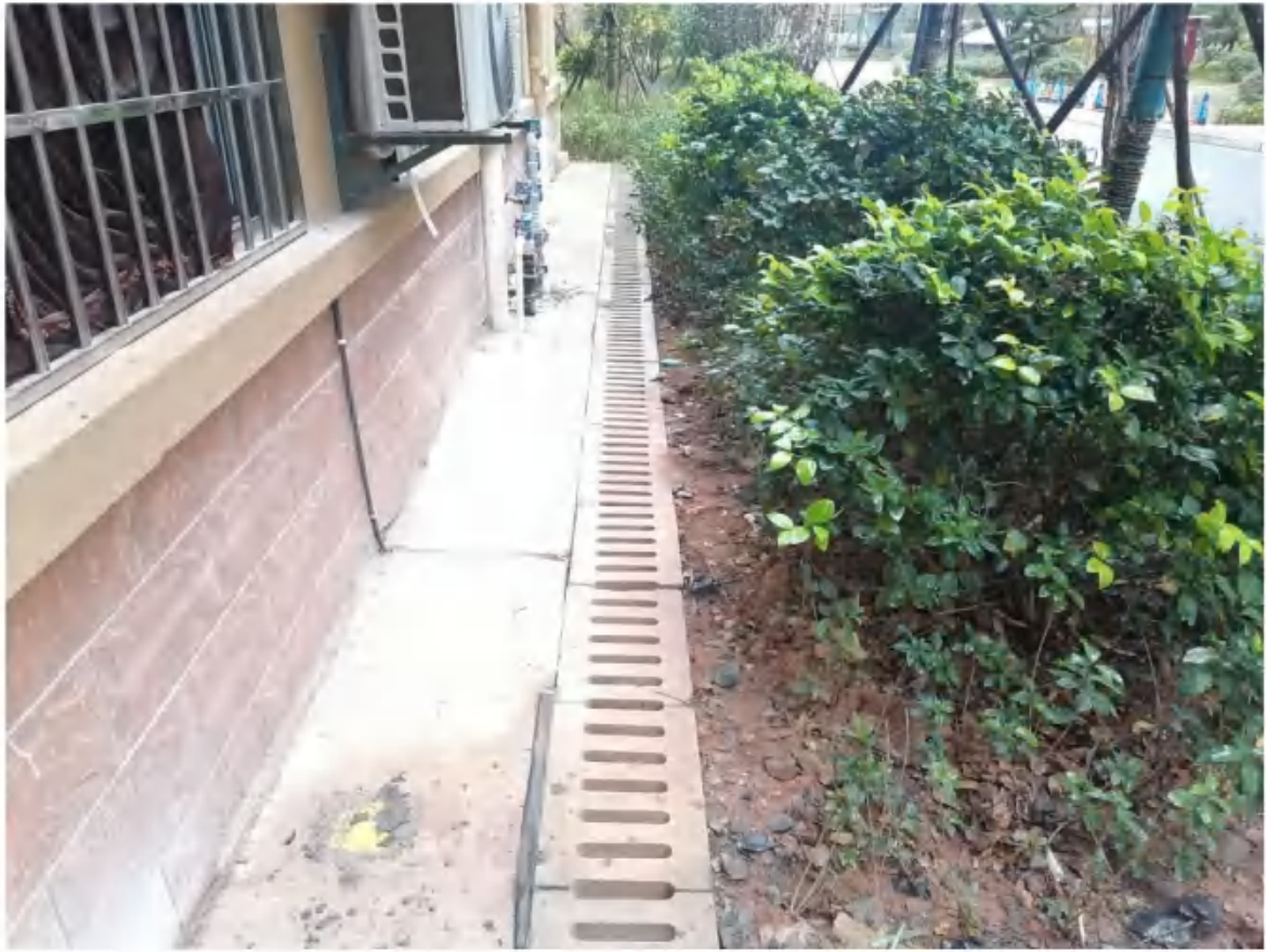
盖板排水沟和景观绿化（2022年10月）
