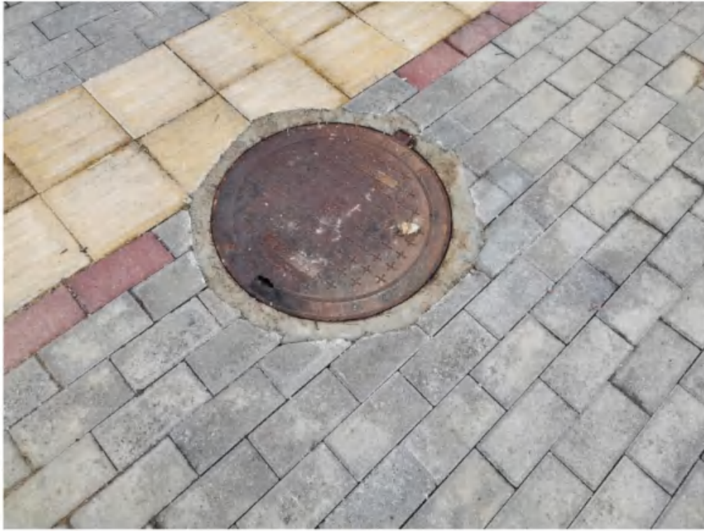
降雨蓄滲和雨水井（2022年10月）
