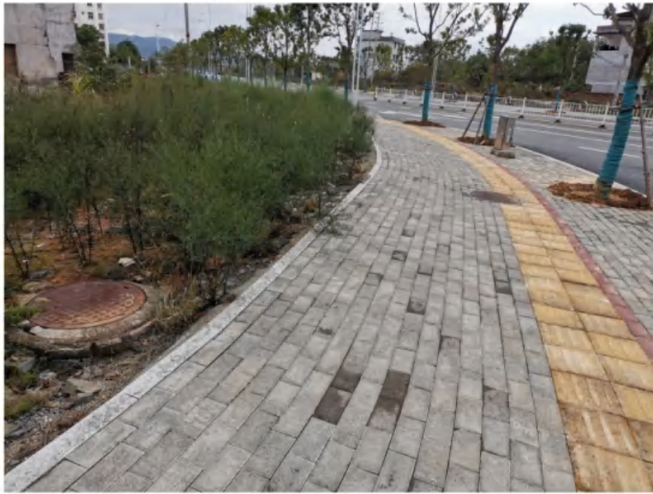
撒播草籽和透水铺装（2022年10月）
