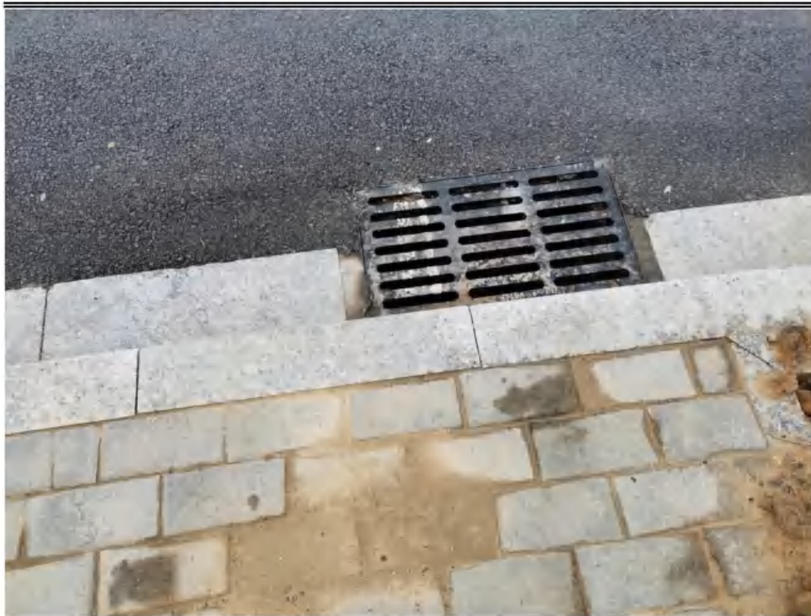
2022年10月现场主体工程区排水措施实施情况
