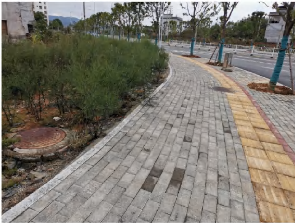
撒播草籽和透水铺装（2022年10月）
