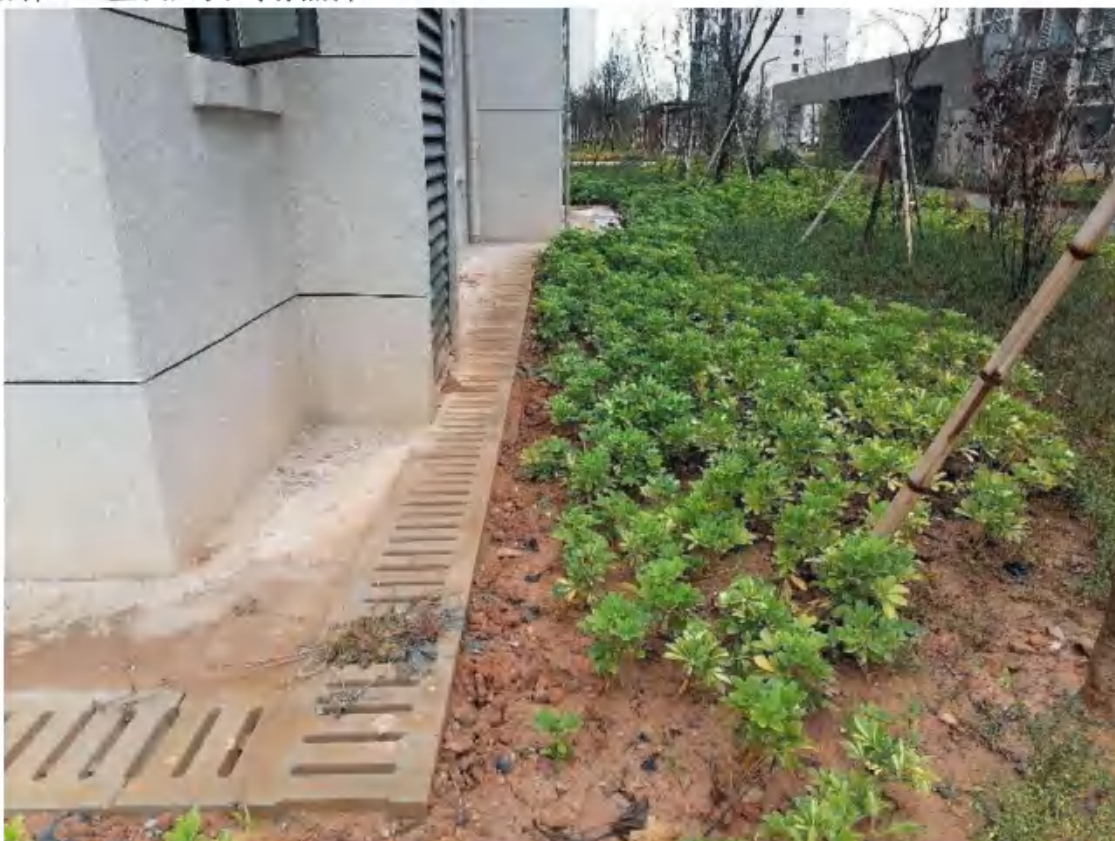
建构筑物区盖板排水沟、景观绿化（2022年11月）
