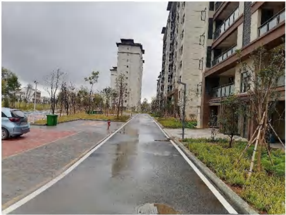
广场道路区透水铺装、景观绿化（2022年11月）
