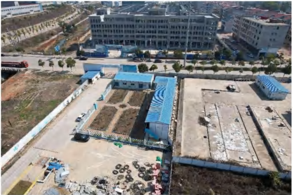
施工临时用地区景观绿化（2022年11月）
