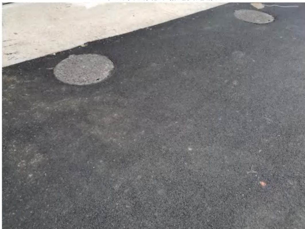
2022年12月现场排水措施实施情况
