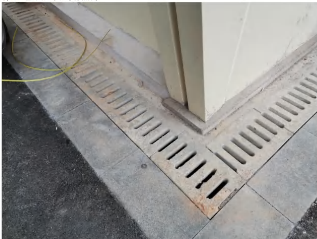
2022年12月现场排水措施实施情况
