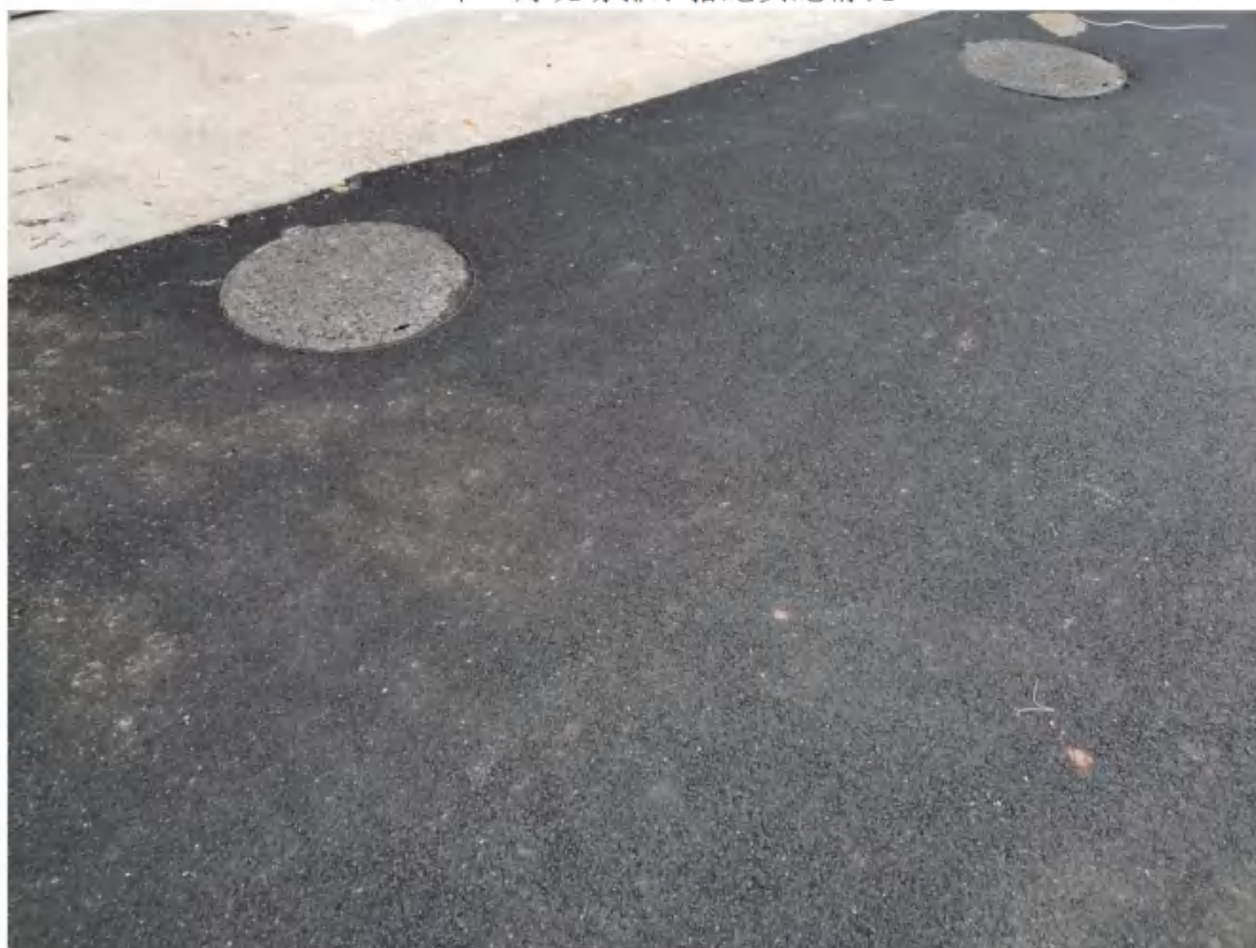
2022年12月现场排水措施实施情况
