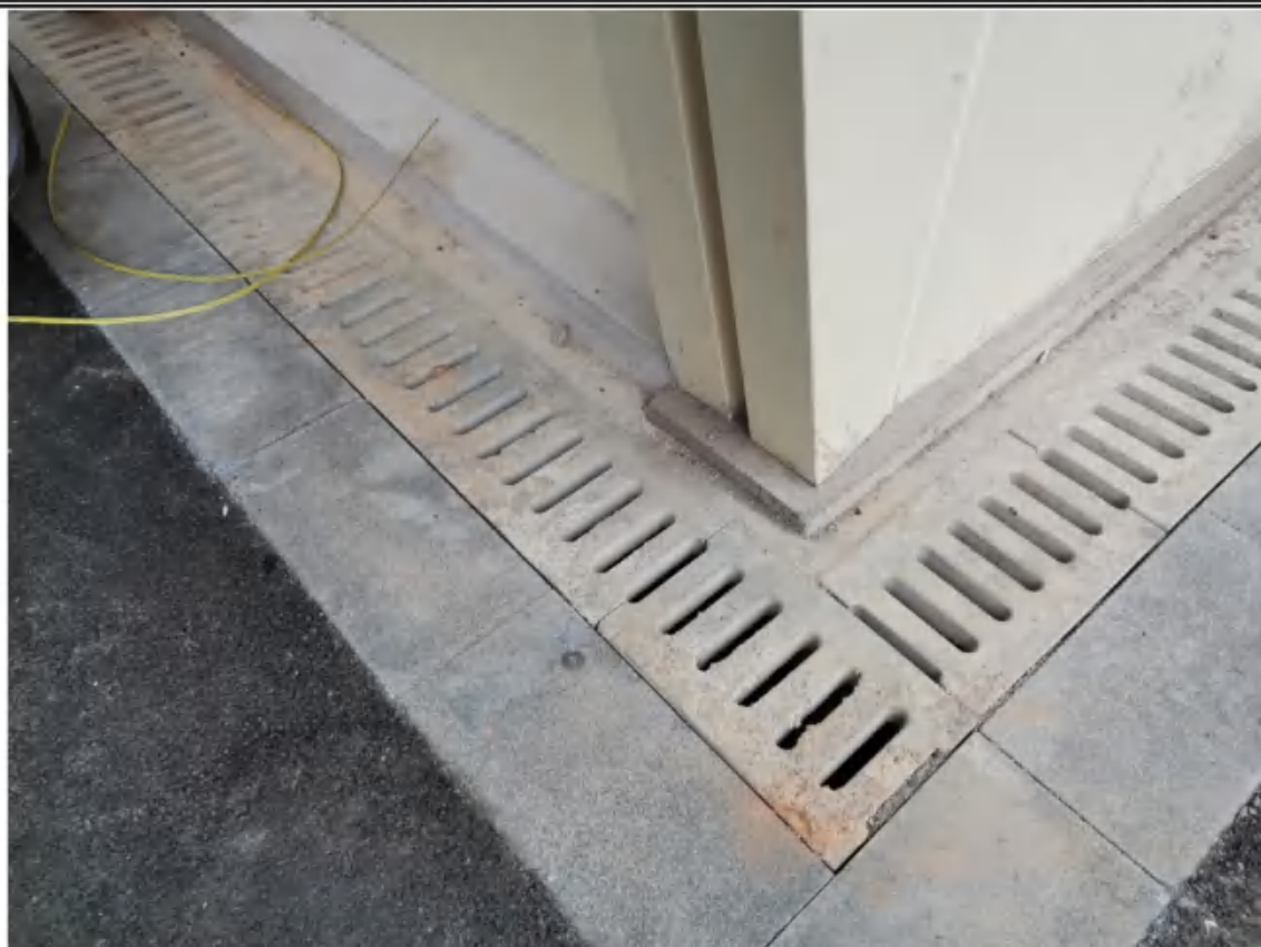
2022年12月现场排水措施实施情况
