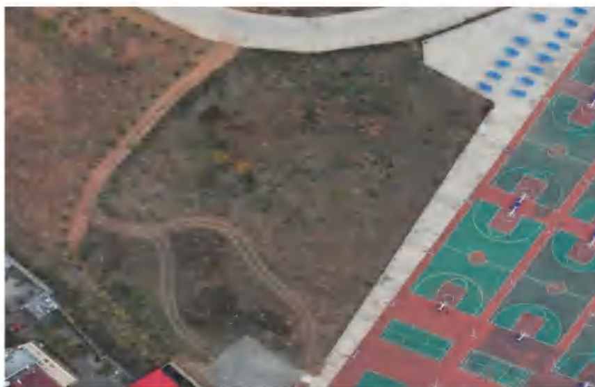
2022年11月现场景观绿化区绿化措施实施情况
