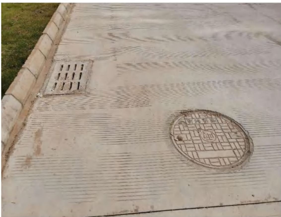
雨水口及雨水井措施（2022年11月）
